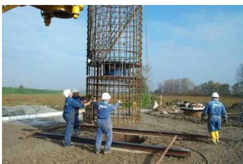
Imagen 6: Ejemplo de pinchado de armaduras en pilas
