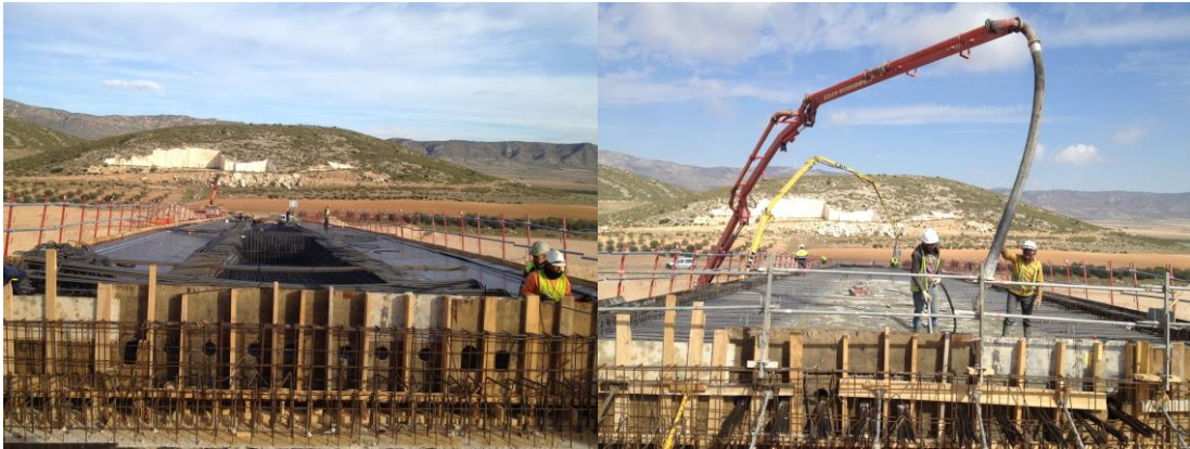
Imagen 12 (izq) Ejemplo de montaje de ferralla sobre un tablero de cimbra
