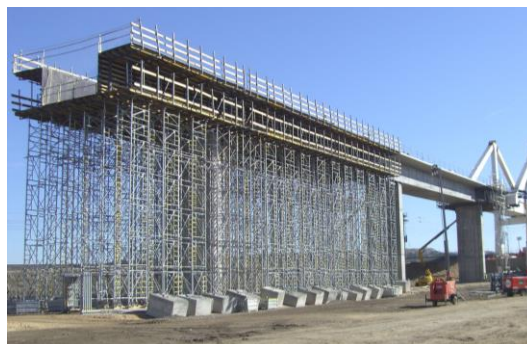
Imagen 10 Ejemplo de cimbra montada
