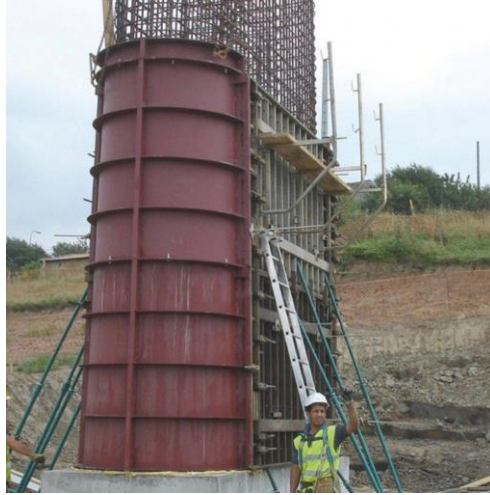
Imagen 7: Pila preparada para ser hormigonada
