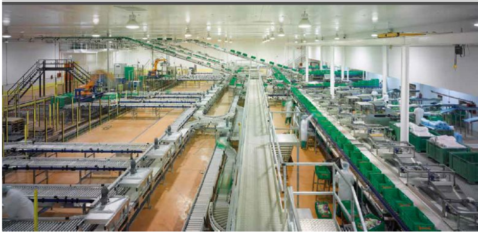
Ilustración 3: Instalaciones de Agromediterránea. Fuente: MEMORIA (2014).
