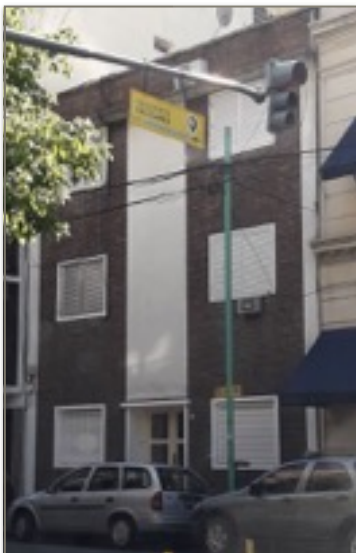
El edificio desde la calle Ecuador.
