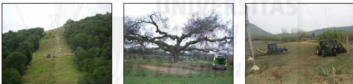
Figura 10. Ejemplos de trabajos realizados por la empresa.
