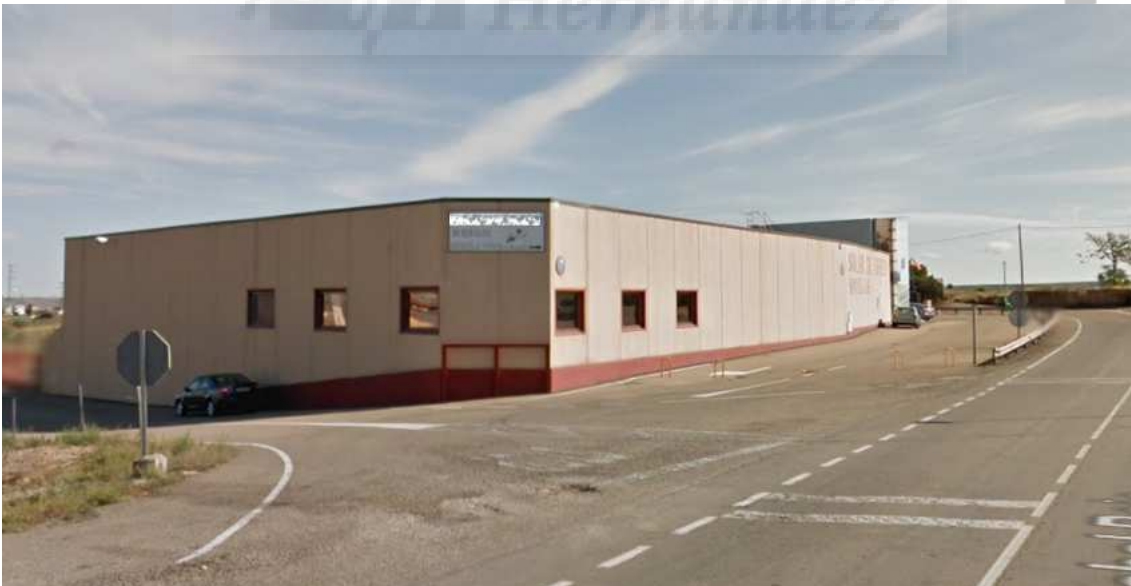
Fig. 8.- Fachadas laterales de la bodega. La que aparece soleada tiene la orientación más conveniente (Sureste) para ubicar la instalación solar (Google Maps, 2018d).
