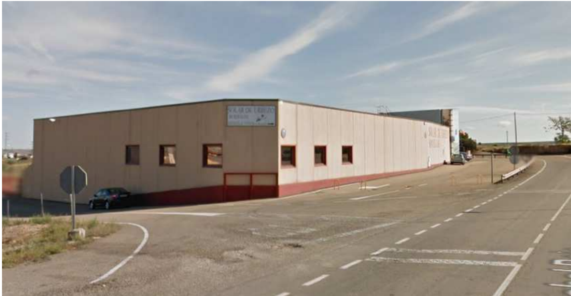
Fig.51.- Fachada con orientación Sur-Este, donde puede verse la zona con cubierta plana donde se instalará el campo de captadores.
