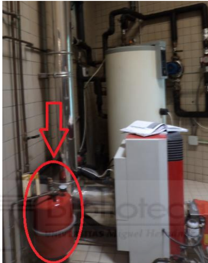
Figura 4: Vaso de expansión circuito primario
