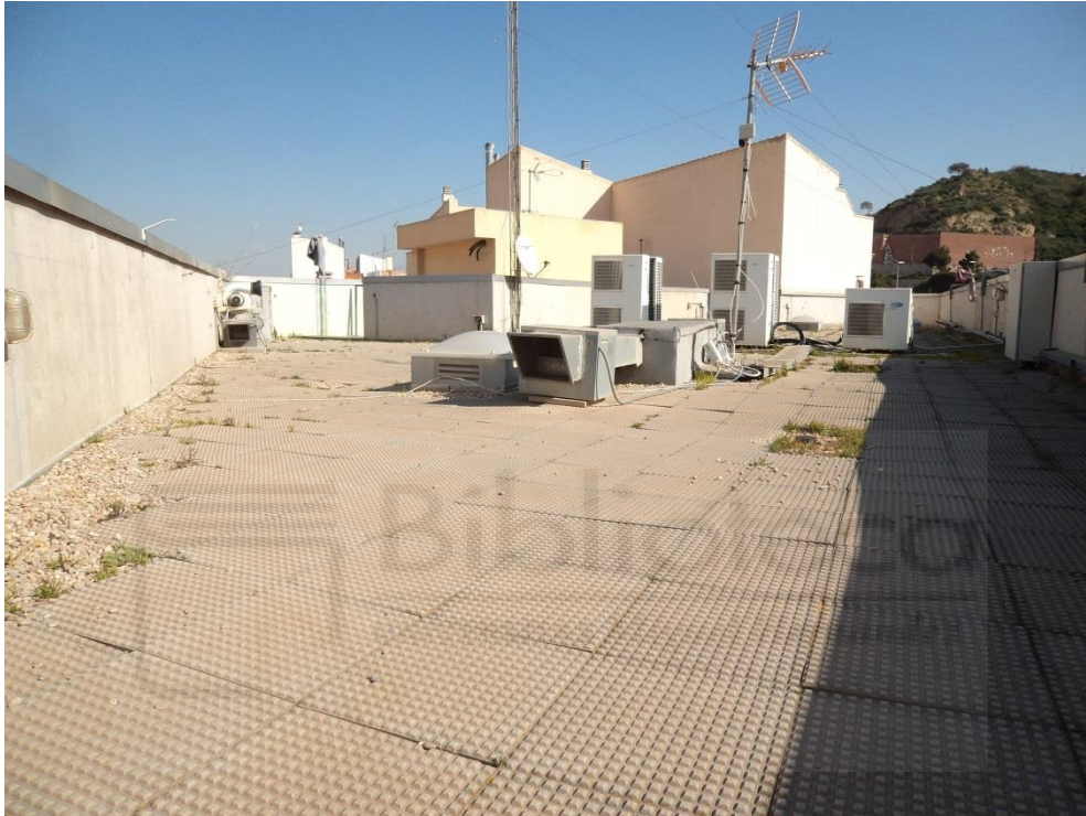
Figura 9: Azotea parquet de Bomberos Jaime II
