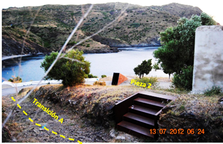
Fig. 24. Escalera de acero corten, Pieza 2 (Fotografía del autor).
