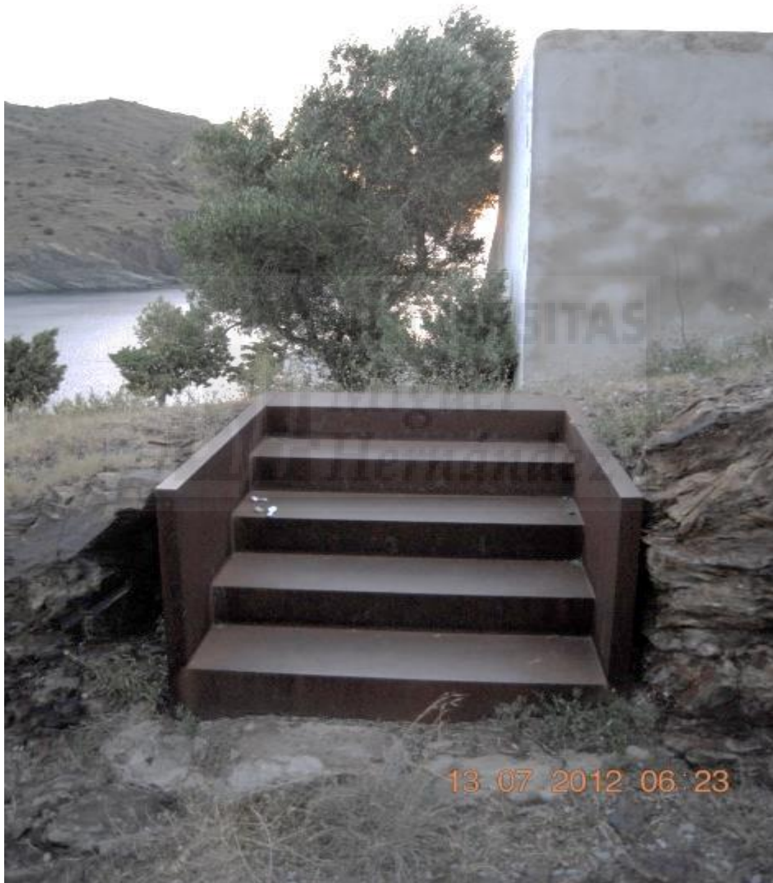
Fig. 13. Pieza 2. Escalera de acero corten (Fotografía del autor).
