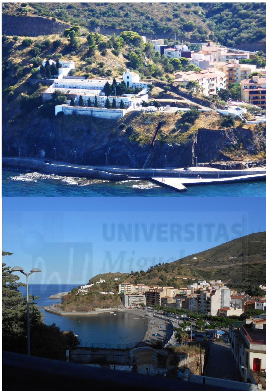
Fig. 14. Vista general del espacio de Pasajes (Fotografías del autor).
