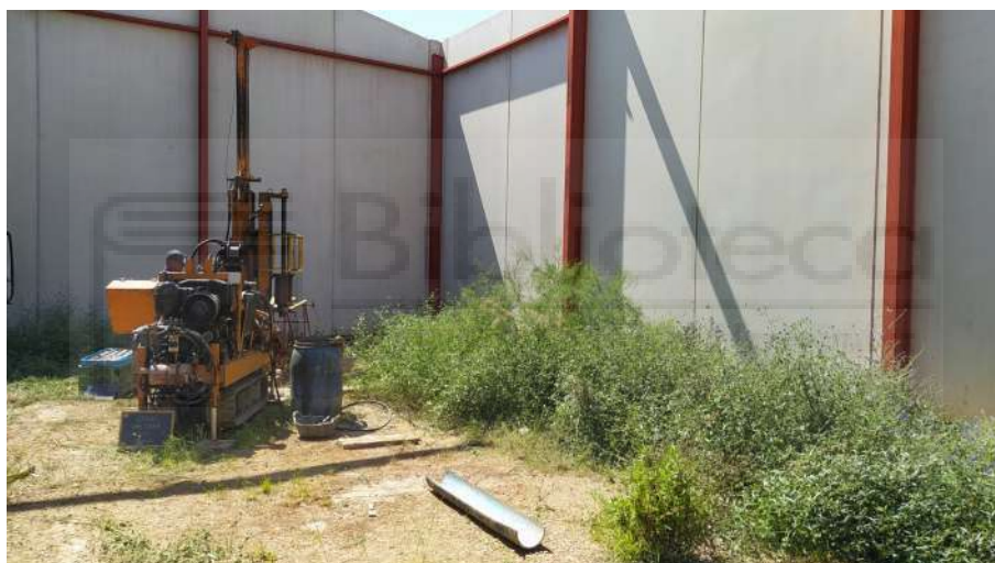
Máquina de sondeos realizando trabajos de campo. Emplazamiento Sondeo 2.
