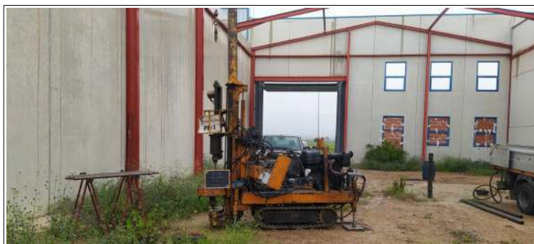
Imagen 1. Estado actual de la parcela
