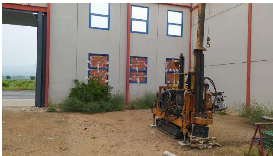
Máquina de sondeos realizando trabajos de campo. Emplazamiento Sondeo 1.
