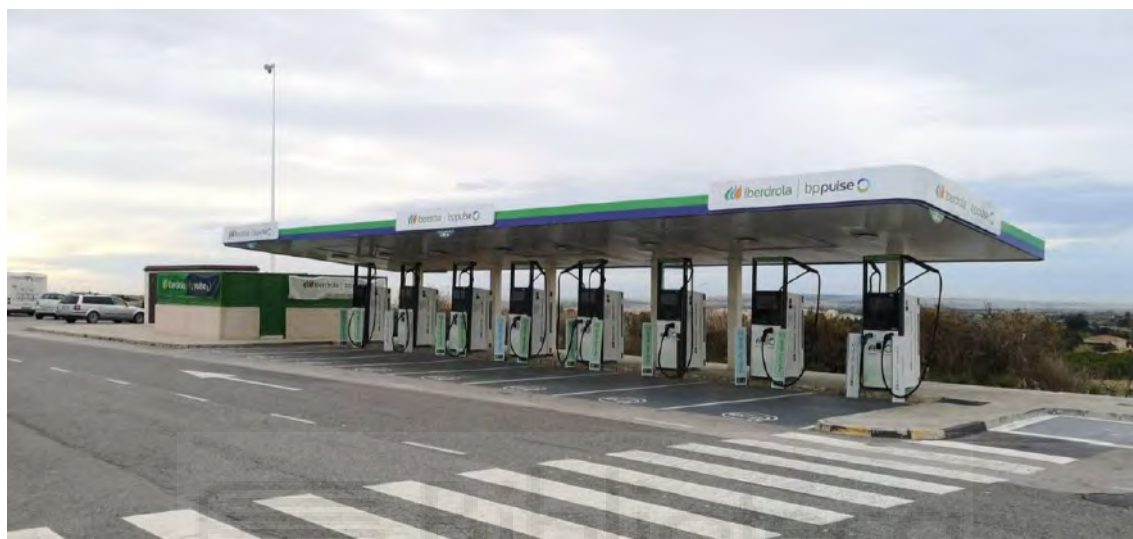
Figura 1.51: Estación de recarga Iberdrola/BP Pulse con 8 puntos de recarga con conectores CCS y CHAdeMO
