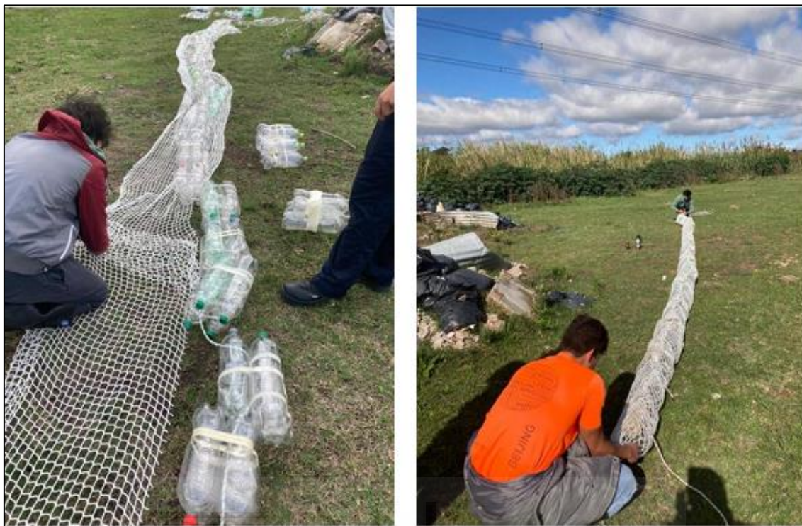
Figura 12: Imágenes de la construcción de la biobarda del Informa Final CSIC IM
