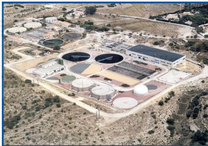
Figura 1: Fotografía aérea EDAR Monte Orgegia (Alicante).
