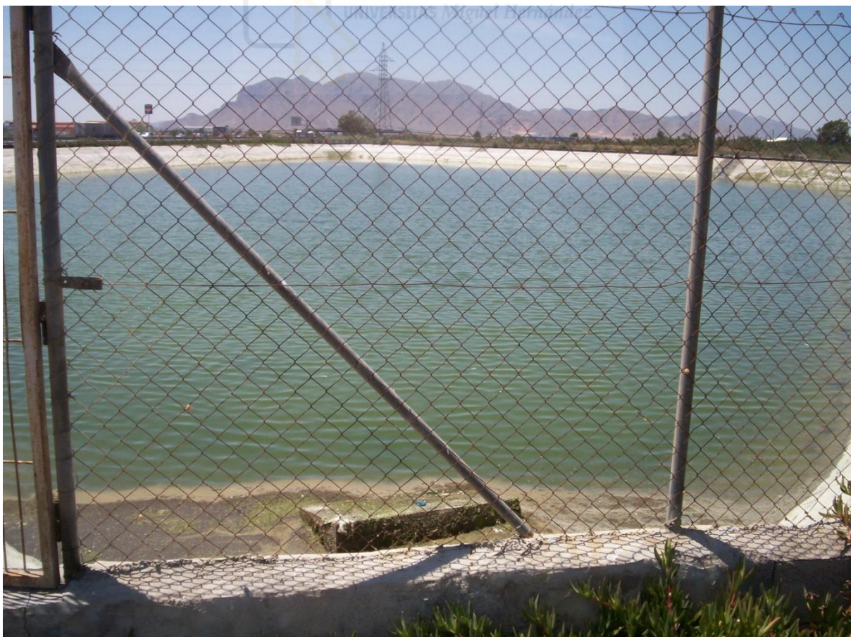
Vista general de otra de las Balsas de La CR de Albaterra.
