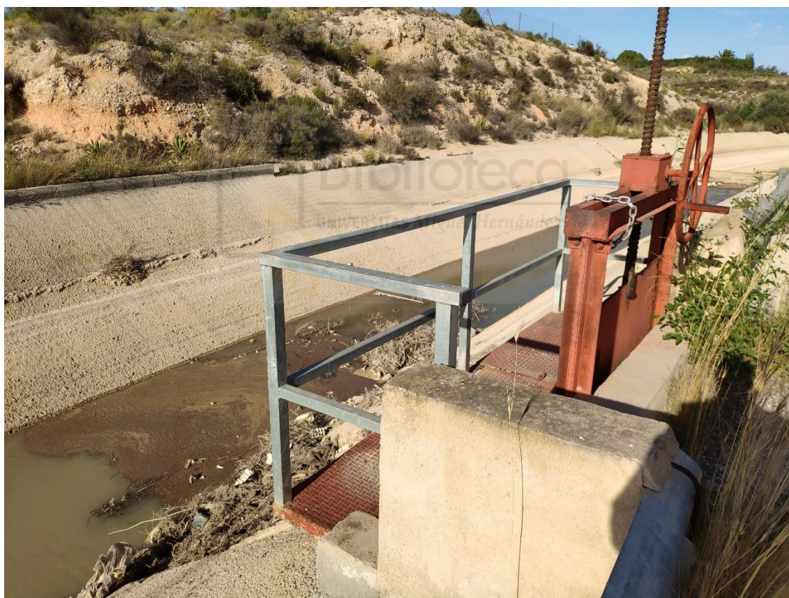
Toma del canal del Trasvase Tajo – Segura
