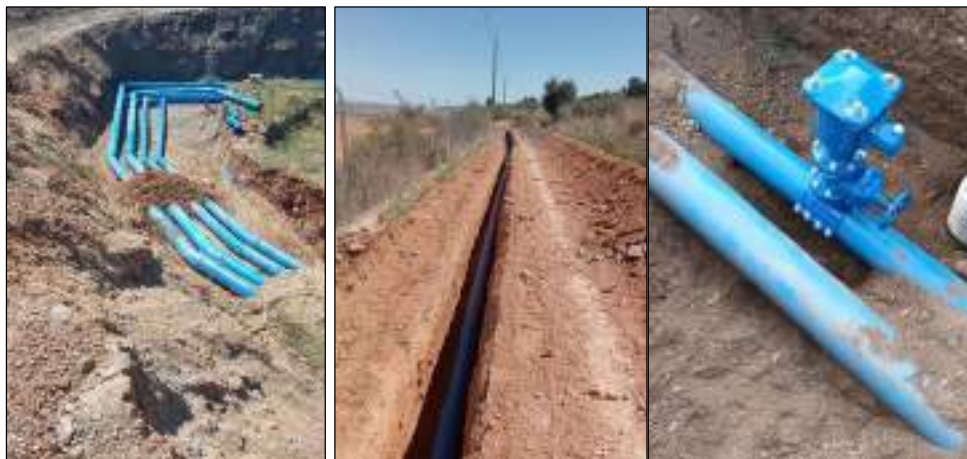
Imagen 40: Instalaciones de tubería PVC-O en obras similares realizadas.
