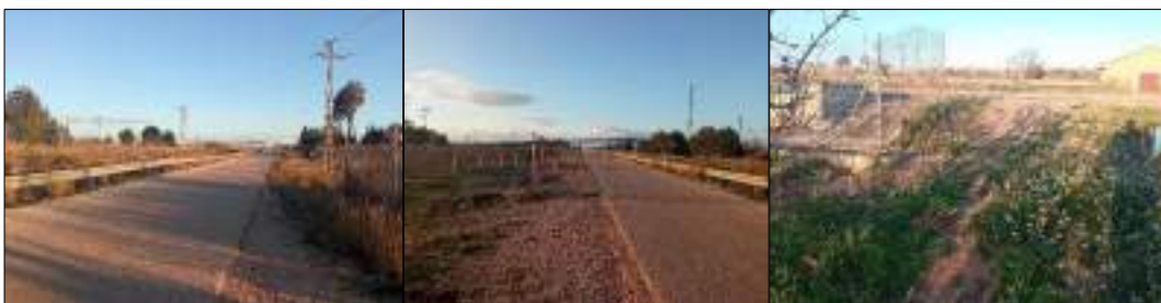
Imagen 30: Accesos a la zona de obra
