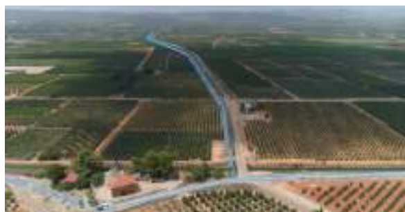
Imagen 1: Red en alta. Conducción bajante, centro de control e inicio de las colectoras Norte y Sur.
