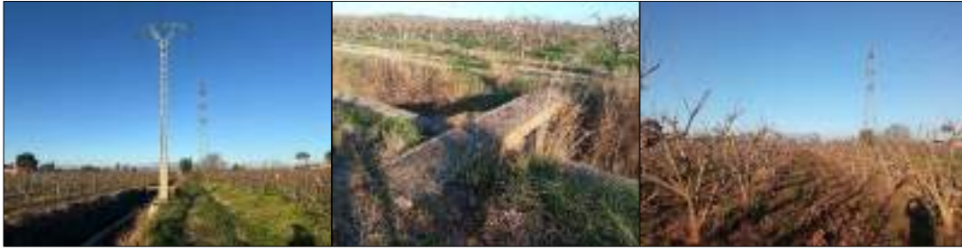
Imagen 31: Accesos a la zona de obra
