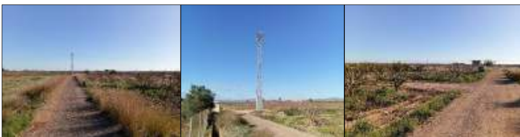
Imagen 33: Accesos a la zona de obra
