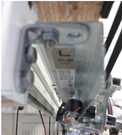
Figura 51. Perfil de la viga principal y su anclaje mediante las escuadras metálicas.
