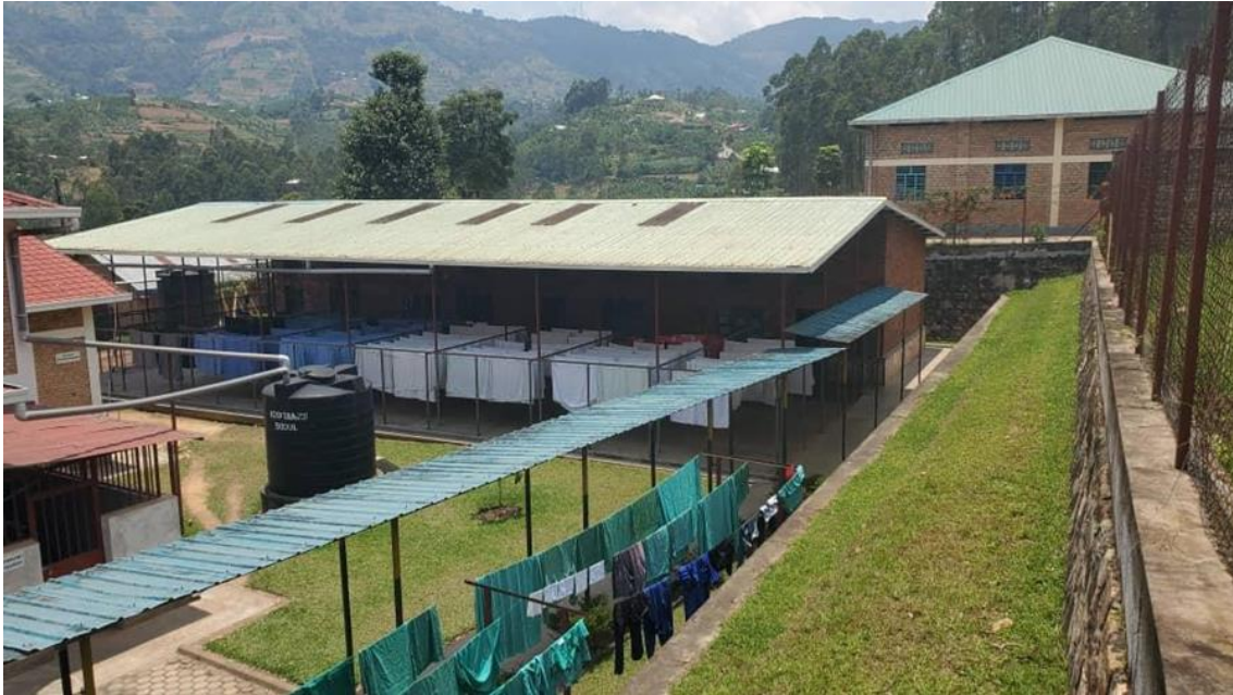
Ilustración 35. Edificio Lavandería Hospital de Nemba
