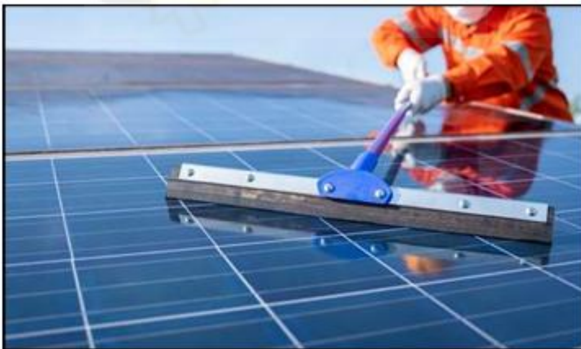
Ilustración 49. Limpieza paneles solares.
