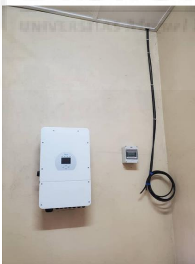
Ilustración 38. Instalación del inversor.
