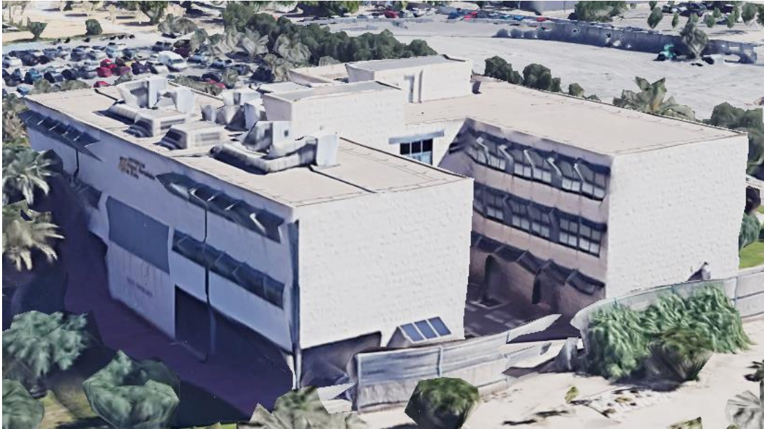
Figura 26. Vista aérea del Edificio Torreblanca en Google Earth.
