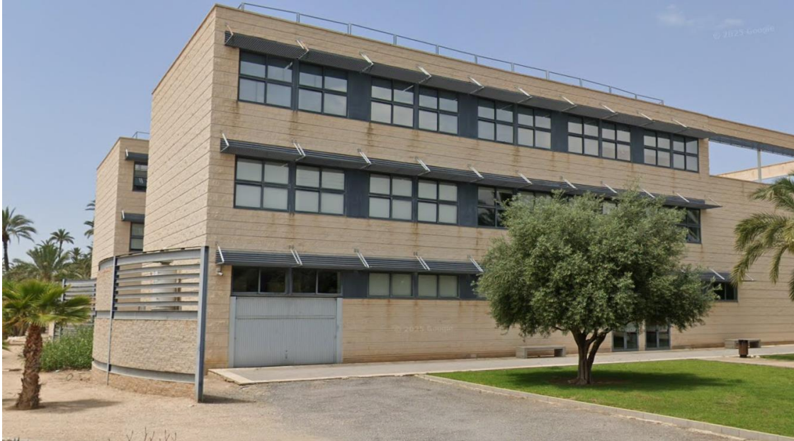
Figura 16. Vista del edificio donde se observan los elementos de sombra fijos del edificio.
