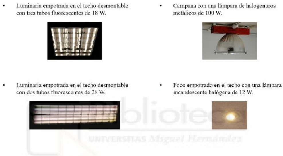
Figura 19. Tipos de luminarias actuales en el edificio Torreblanca.
