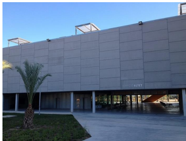
Figura 3. Fachada exterior edificio Altet
