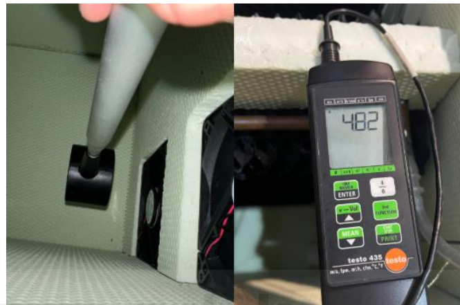
Figura 63. Medición del caudal de aire interior
