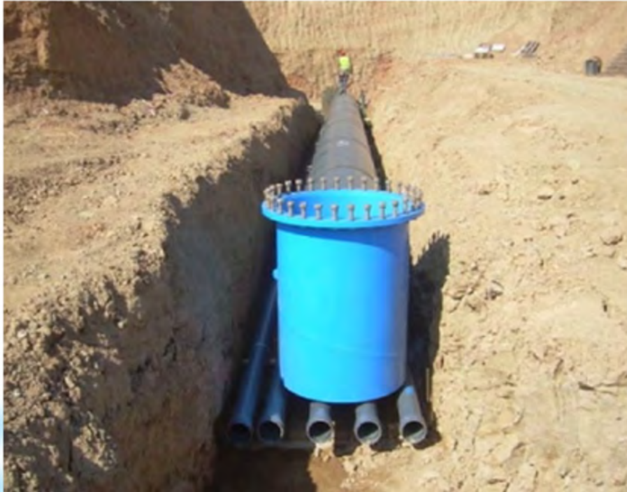
Fotografía 18. Toma de fondo y colectores de drenaje
