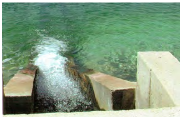
Fotografía 12. Sistema de entrada de agua mediante vertido directo sobre canal
