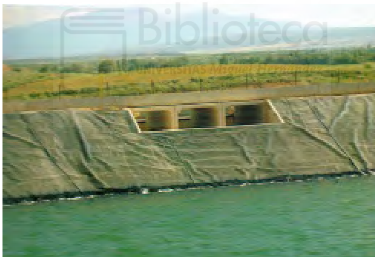
Fotografía 25. Aliviadero en marco
