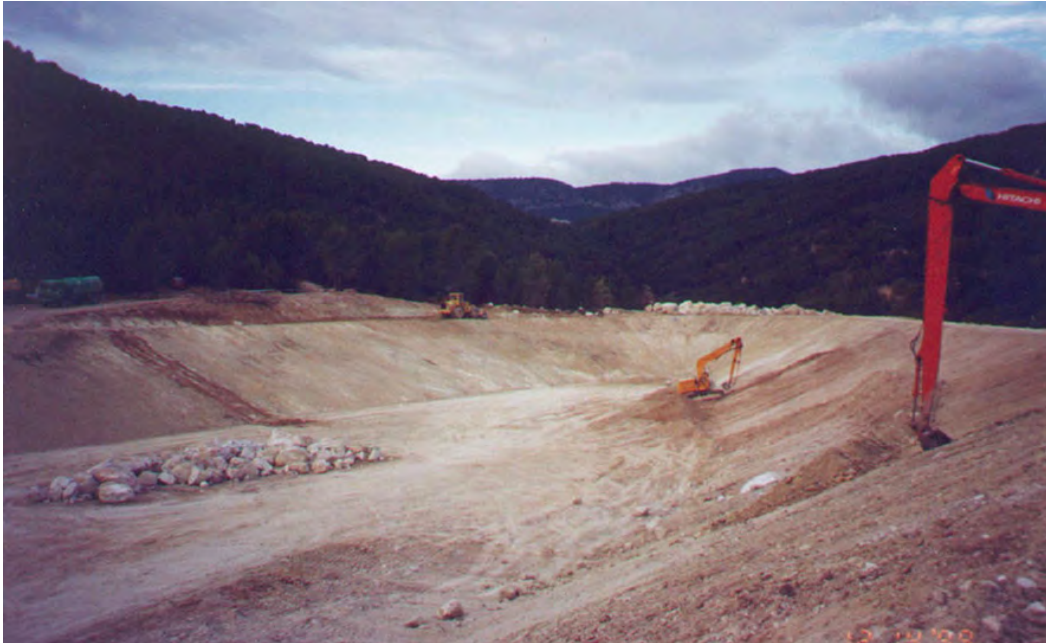
Fotografía 8. Perfilado de taludes
