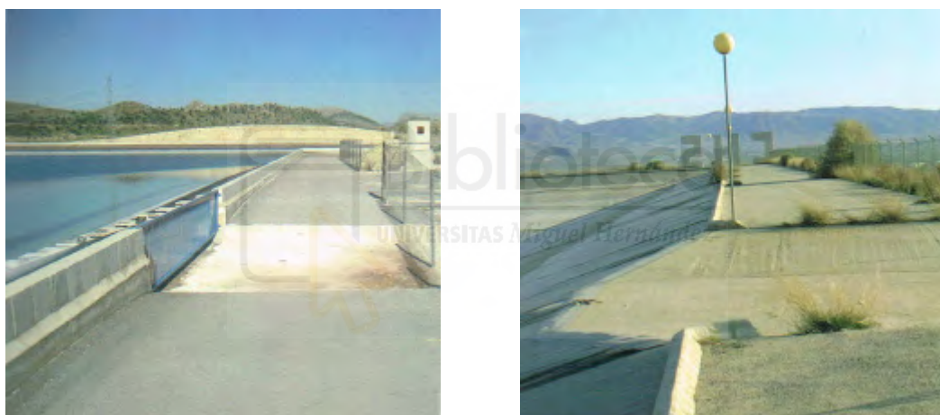
Fotografía 26. Aliviadero en badén
