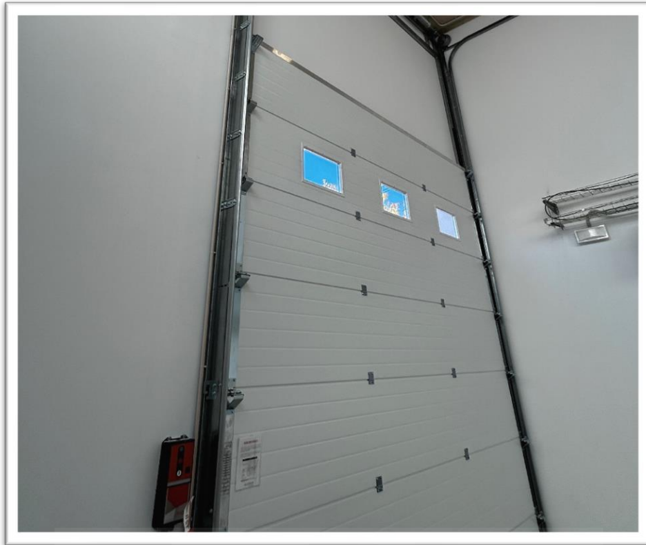
Figura 104: Portón ubicado en una de las paredes del Laboratorio IME 1.
