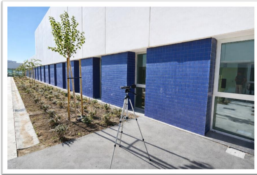
Figura 49: Disposición de la fuente y el sonómetro en el patio exterior del edificio frente a fachada colindante al Laboratorio IME 1.
