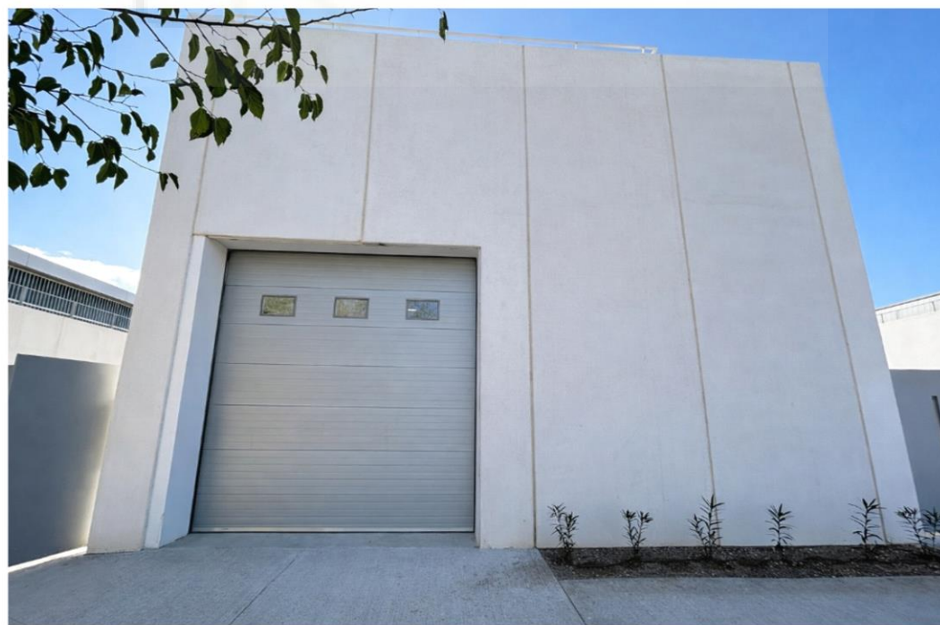
Figura 41: Fachada con portón del Laboratorio IME 1 colindante a la zona exterior del edificio.
