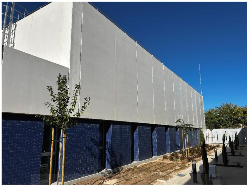
Figura 40: Fachada del Laboratorio IME 1 colindante al patio exterior.
