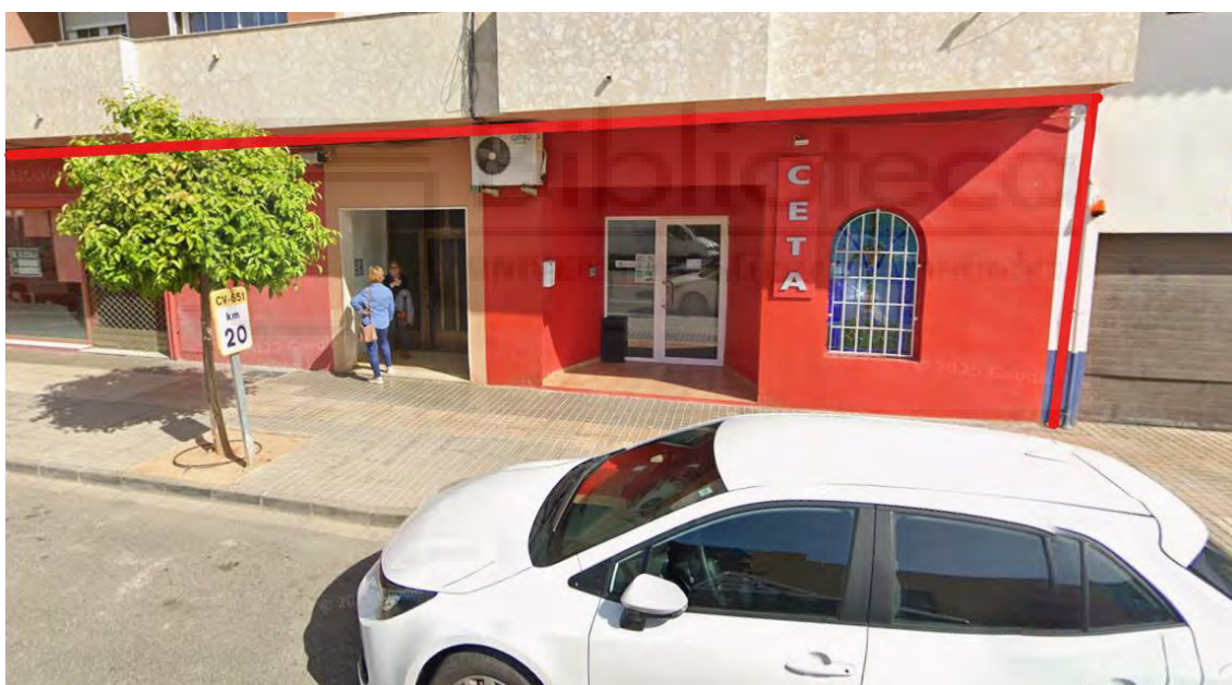
Figura 10. Trazado cable salida cabecera Aielo Malferit desde Correos 2.
