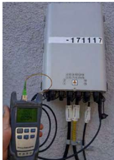
Figura 41. Ejemplo medida nivel potencia CTO La Pineda. [10]
