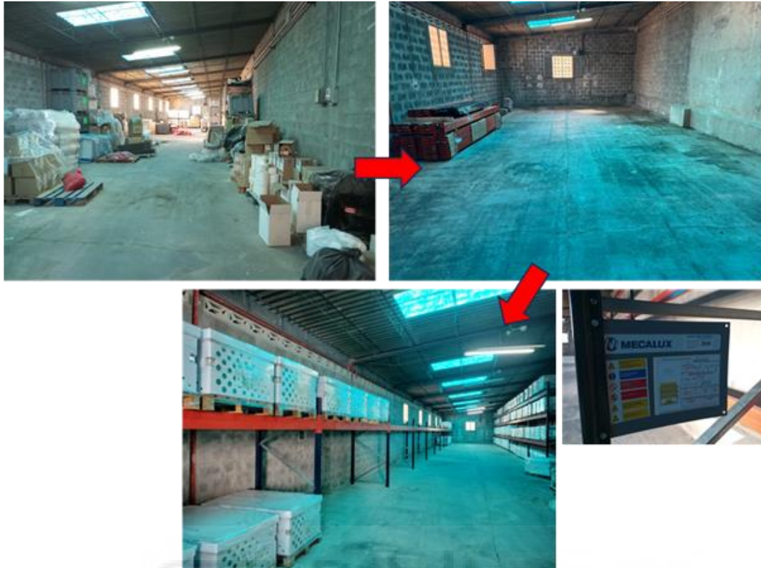
Figura 8. Instalación de estanterías convencionales para almacenamiento paletizado.
