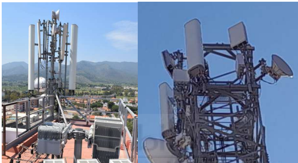
Figura 21 SSRR en azotea y SSRR en torre. Los paneles pequeños son nuevas antenas 5G.
