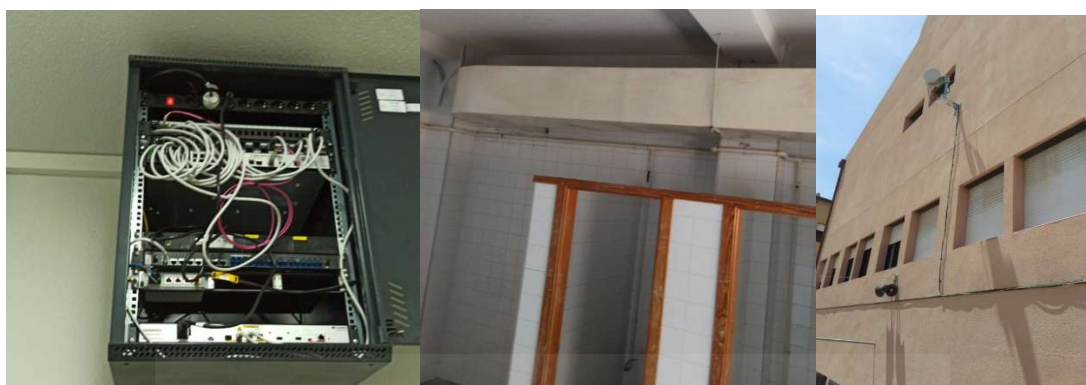
Figura 27 Instalación de radioenlace en sede de cliente
