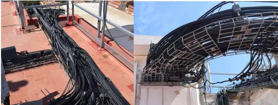
Figura 24 Cableados de distinto tipo que discurren por bandejas o torres para conectar los equipos
