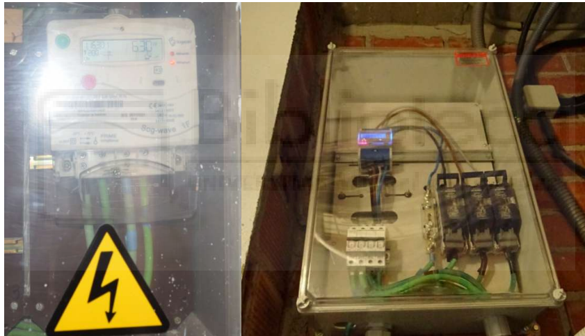
Figura 10 Suministro desde contador propio y Cedido por la propiedad con contador testigo
