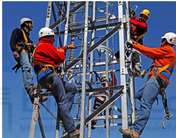
Figura 30 Trabajos en altura anclados con distintos medios
