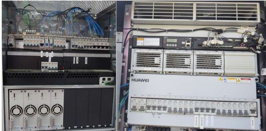
Figura 13 Equipos de fuerza con sus módulos rectificadores y disyuntera
