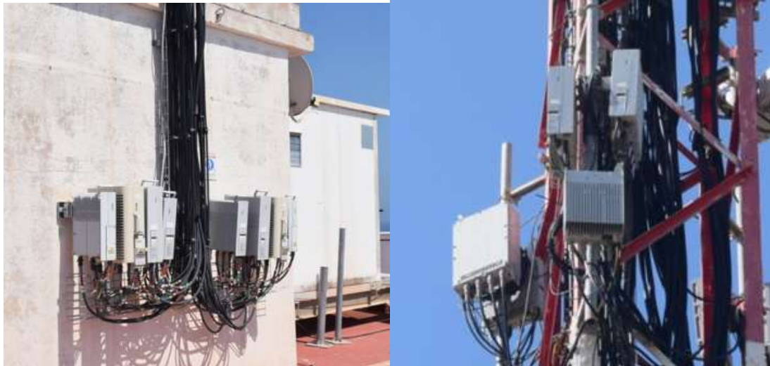
Figura 19 Ejemplo de instalación de RRUs en Azotea o Torre
