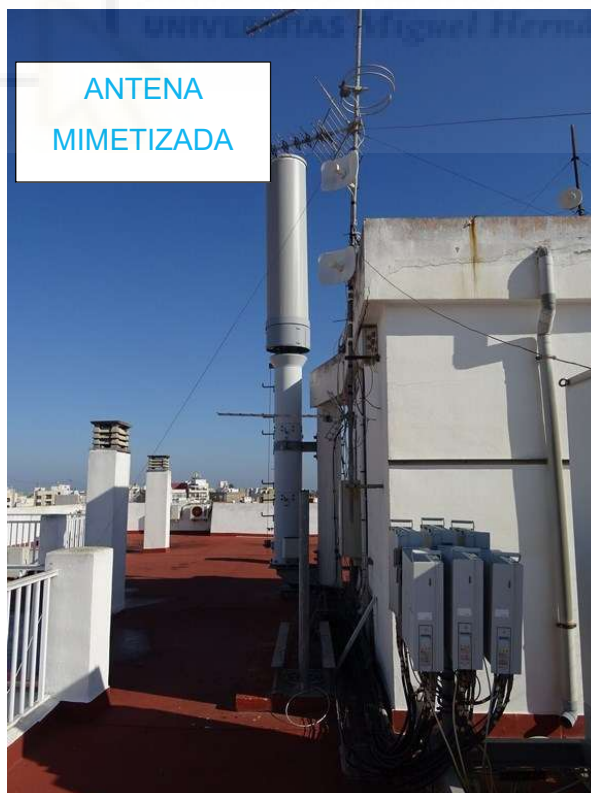
Figura 7 Antena Mimetizada
