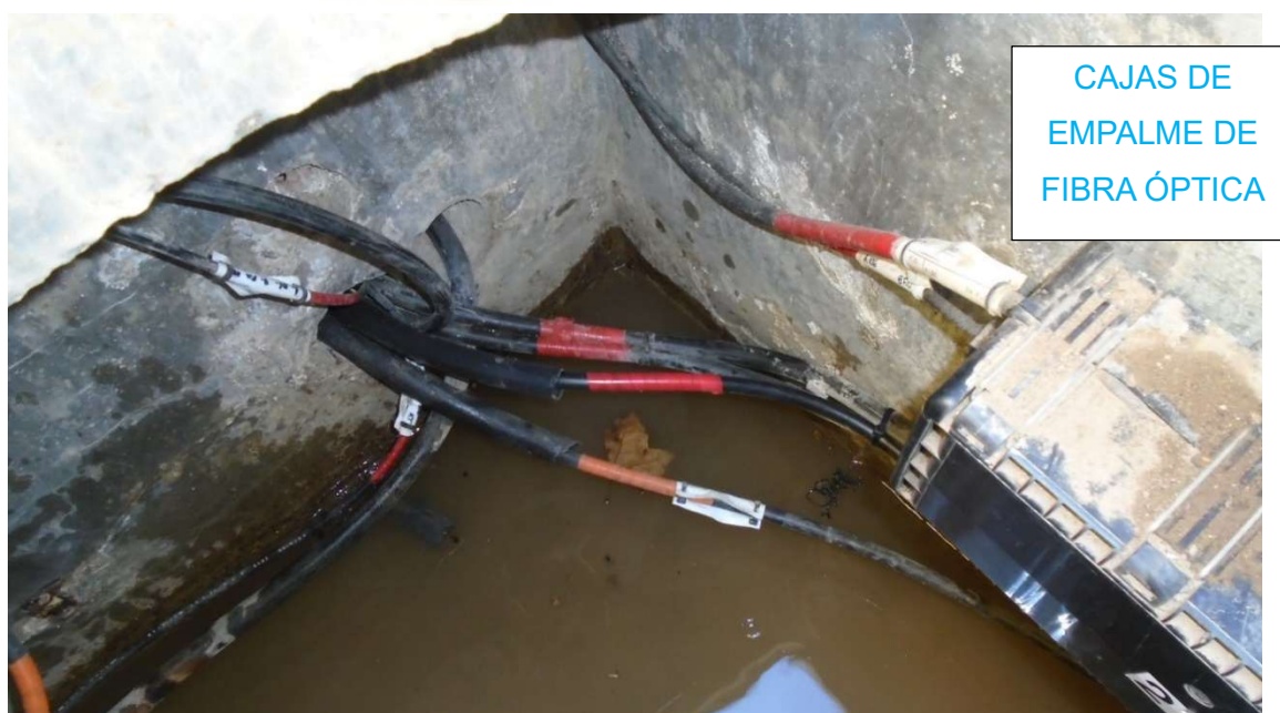
Figura 9 Caja de empalme en espacio confinado
