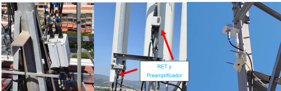
Figura 25 Diplexores, preamplificadores, RET y antena GPS
