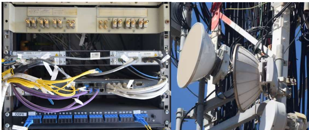
Figura 17 Equipo de Tx Inalámbrica con sus conexiones, tarjetería y parábolas
