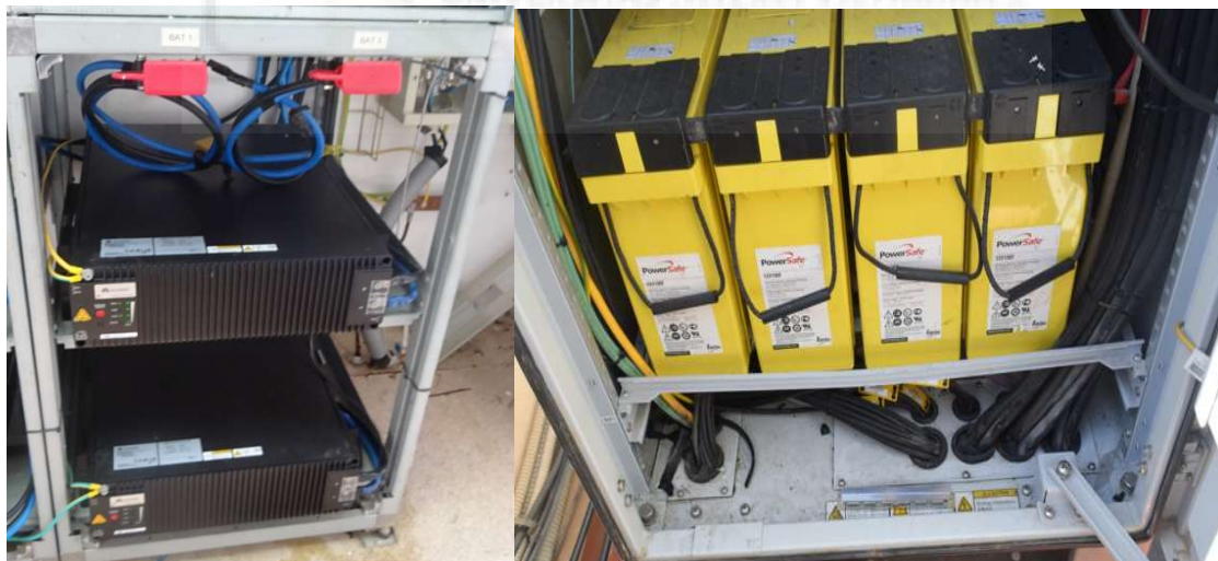
Figura 14 Ejemplo de batería de Litio 48V en interior y Cadena de 4x12V Plomo exterior
