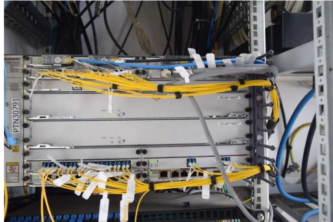
Figura 18 Equipo de Tx Fibra Óptica con sus conexiones de FO y tarjetería
