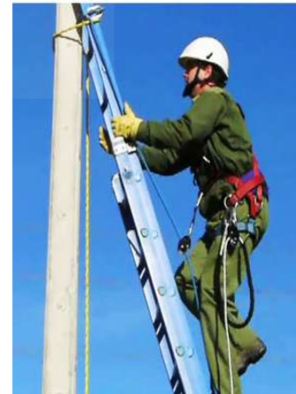
Figura 45 Trabajador equipado con ropa de protección de cuerpo entero, casco con barbuquejo, guantes y arnés anticaídas.
