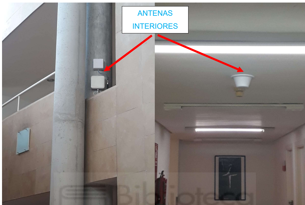
Figura 8 Antenas cobertura interior
