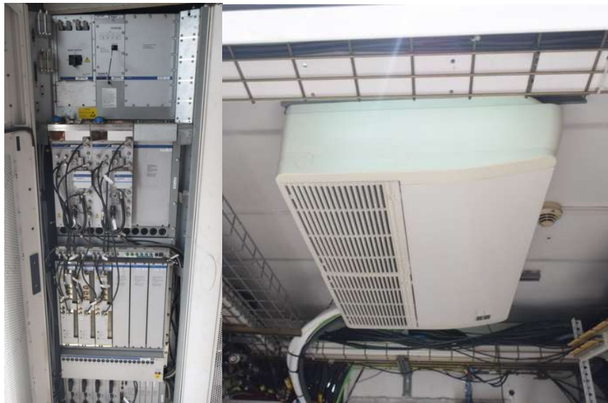
Figura 16 Solución compacta que requería grandes equipos de refrigeración
