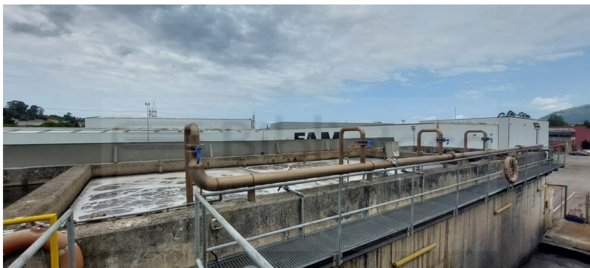
Imágenes 9. Reactor biológico con aireación. Fuente: Elaboración propia.
