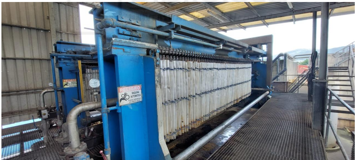
Imágenes 11. Filtros prensa. Fuente: Elaboración propia.
