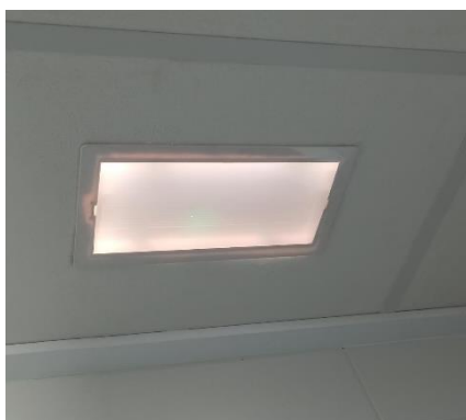
Fig. 30 Luminarias autónomas de emergencia
