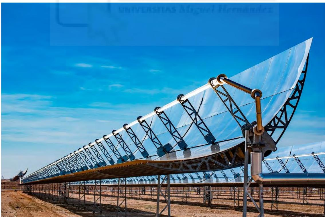
Figura 5. Concentradores lineales cilindro-parabólicos.
