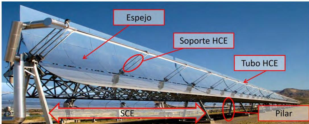
Figura 21. Vista en perspectiva del Solar Collector Element (Elemento Colector Solar) SCE.
