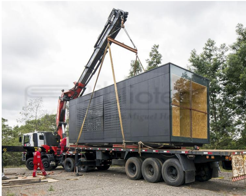
Figura 8 – Ejemplo de transporte y emplazamiento de un módulo prefabricado ( https://www.archdaily.pe/pe/963294/arquitectura-construida-en-fabricas-10-casas-prefabricadas-y-sus-detalles-constructivos )
