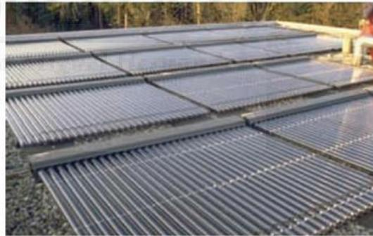
**Captador solar de tubo de vacío**
