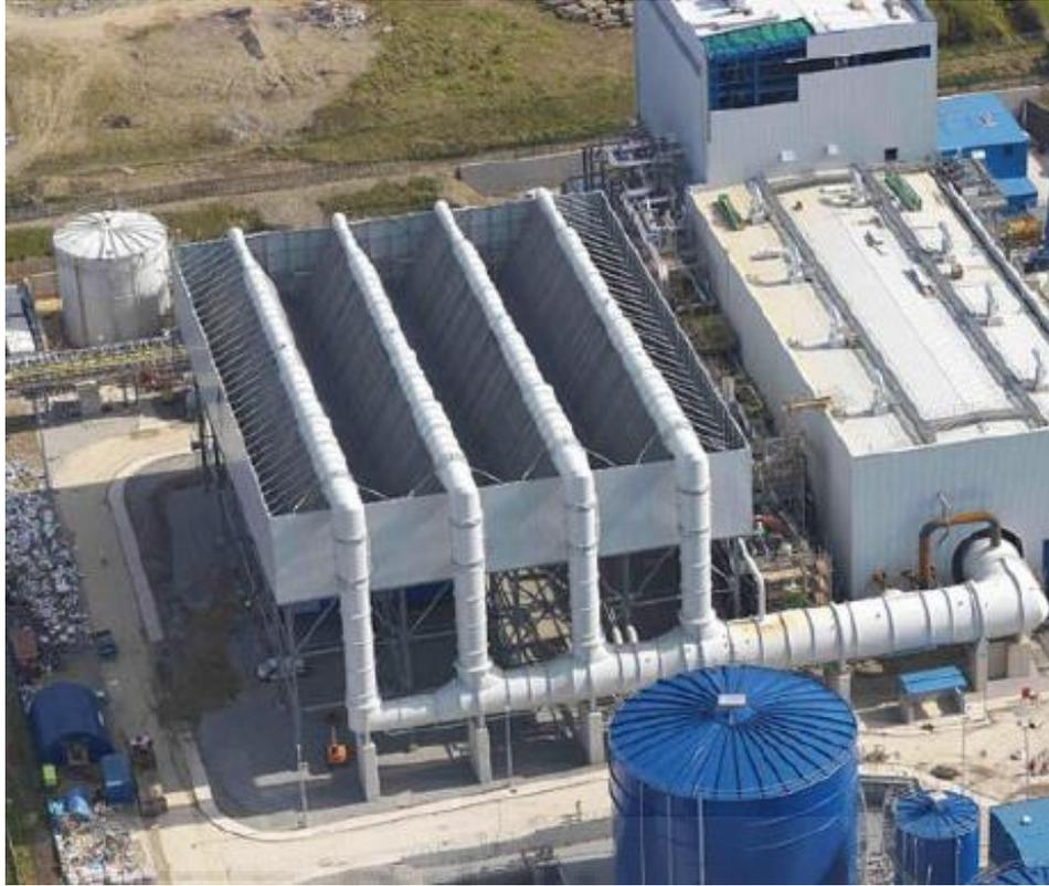
Figura 15. Aerocondensadores
