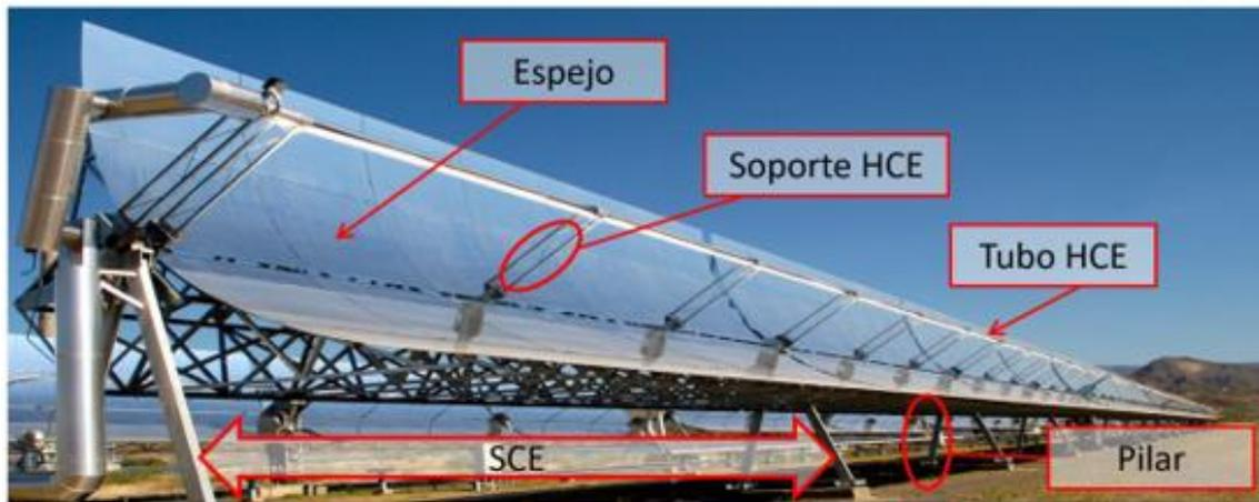
Figura 63. Vista en perspectiva del Solar Collector Element (Elemento Colector Solar) SCE.
