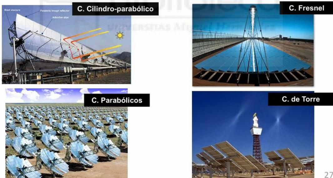
Figura 29. Tecnologías de concentración solar de alta temperatura.
