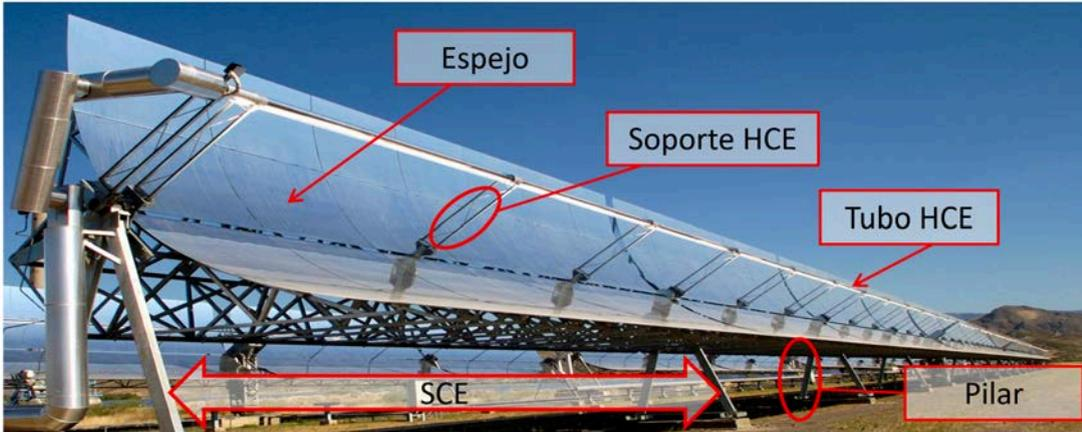
Figura 2.7. Vista en perspectiva e identificación de espejos en un SCE
