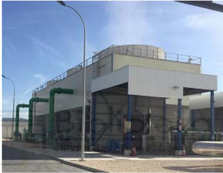
*Figura 2.15. Torre de refrigeración de la planta Enerstar-Villena*
