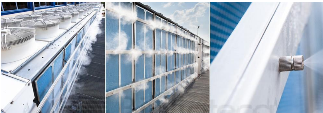
Figura 15. Refrigerador con pre-enfriamiento mediante atomización. Fuente: Blue Energy®
