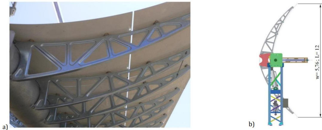
Figura 29. Imagen y esquema del colector SenerTrough (SNT-1), Fredriksson (2019)
