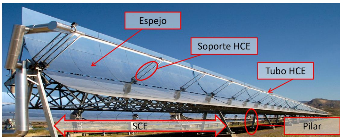
Figura 25. Conexión de Solar Collector Element (Elemento Colector Solar) SCE
