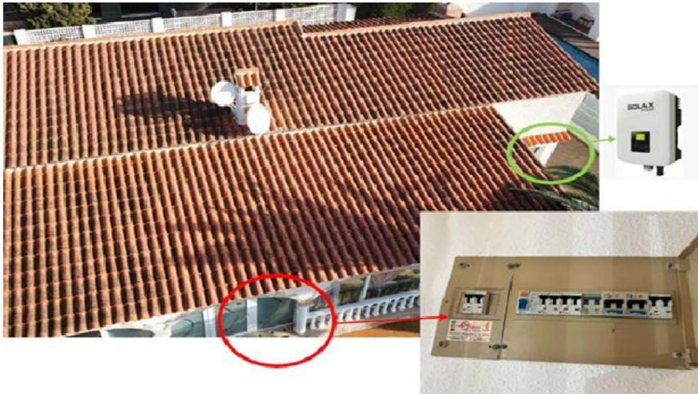
Ilustración 5: Imagen del emplazamiento del inversor y detalle del cuadro eléctrico de la vivienda.
