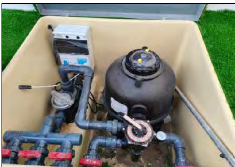
Ilustración 27 Ejemplo de vivienda en ejecución, protecciones en bomba de piscina.
