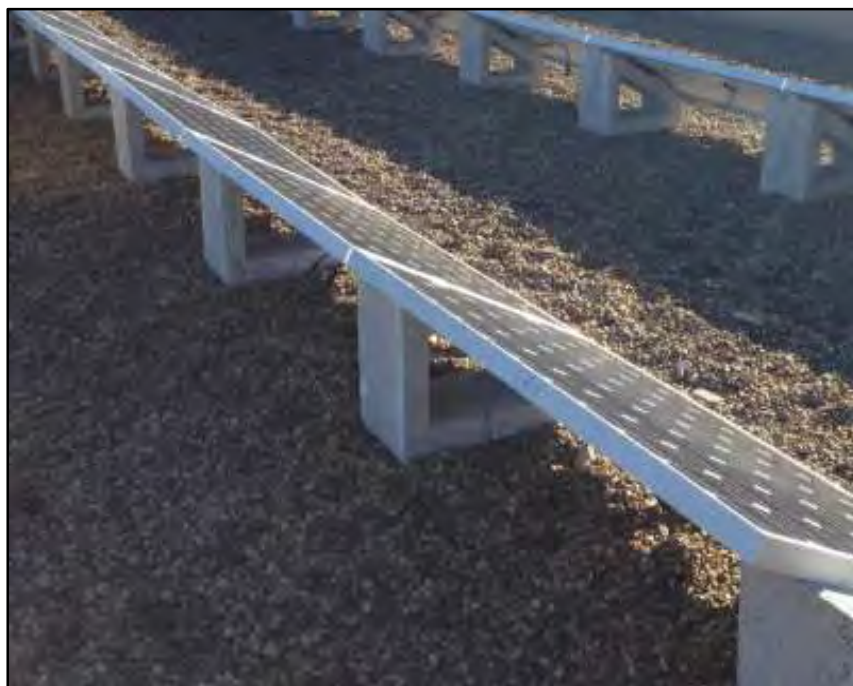
Ilustración 28 Ejemplo de vivienda en ejecución, instalación de paneles solares en cubierta plana.
