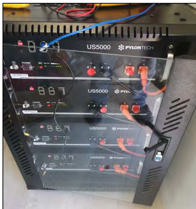
Ilustración 30 Ejemplo de vivienda en ejecución, instalación de baterías.
