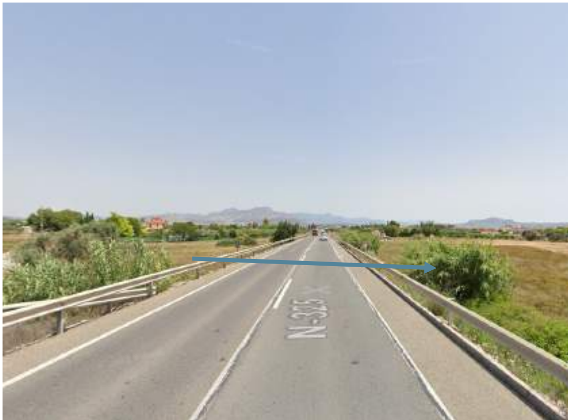
Figura 4: Afección KM.7 CV-84/ N-325.
