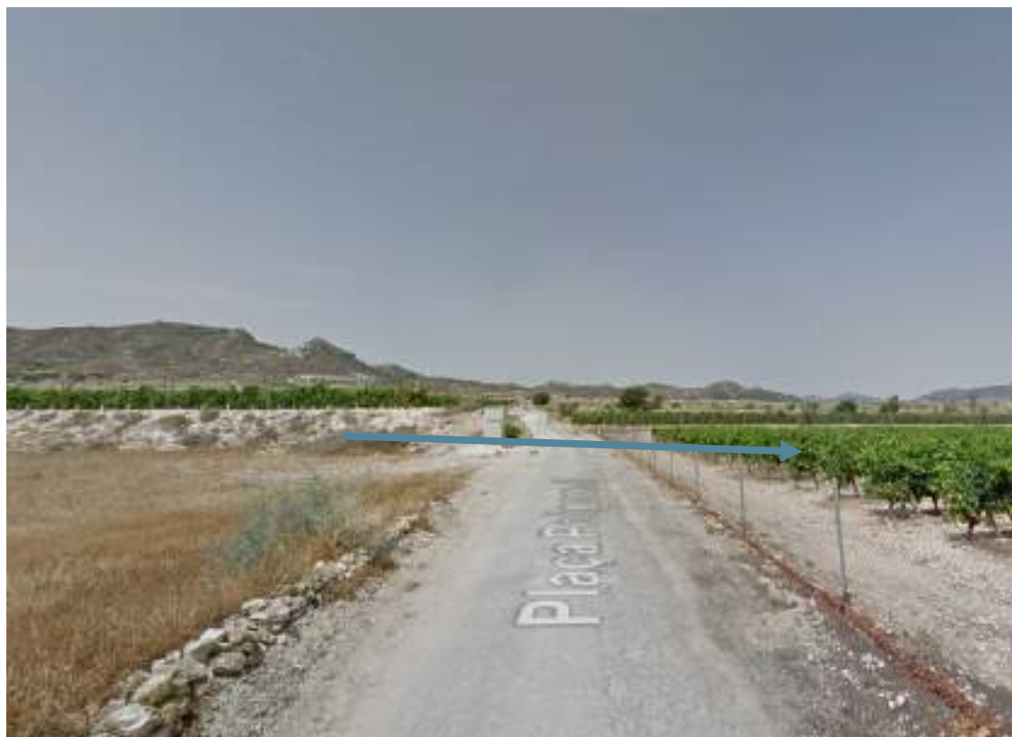
Figura 5: Afección camino rural “Plaça Poligono 42”
