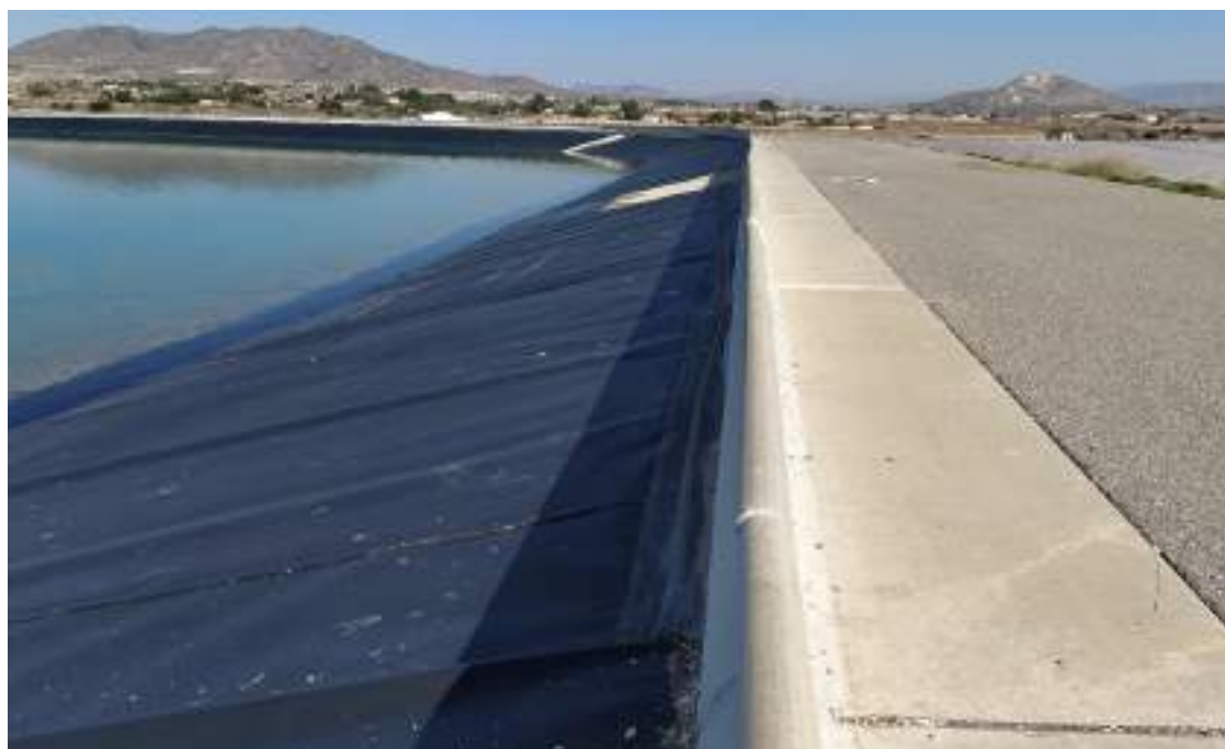
Vista del camino de coronación, bordillo y geomembrana
