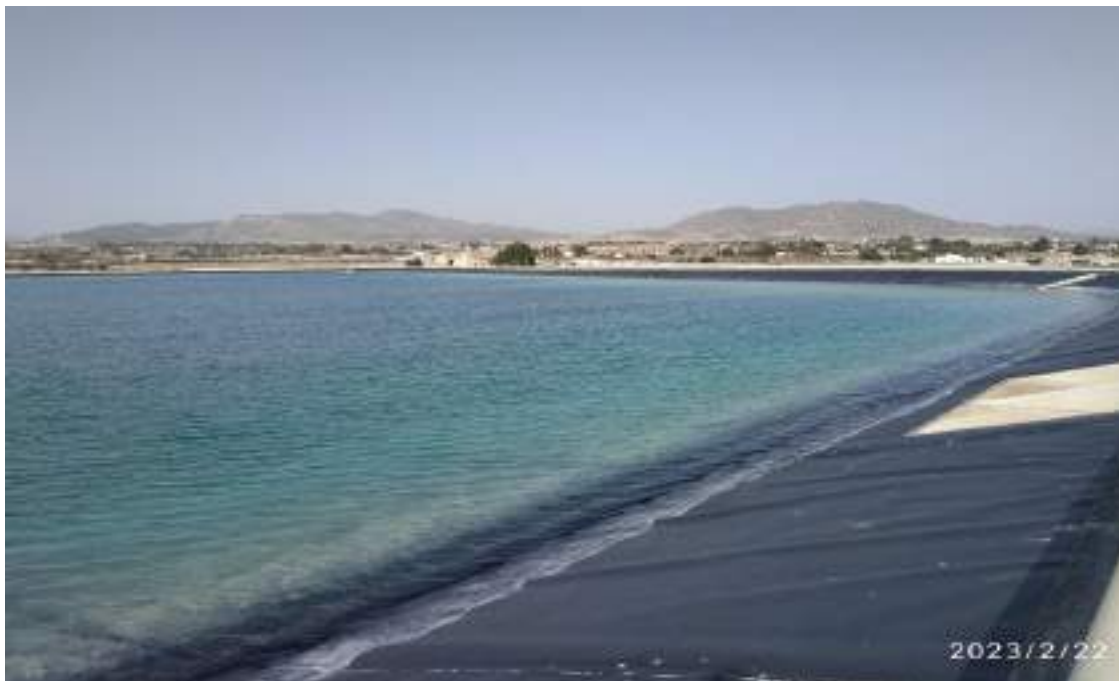
Vista del aliviadero
