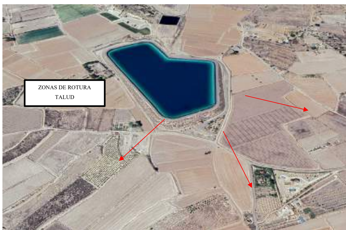
Figura 1: Vista aérea zonas de rotura taludes
