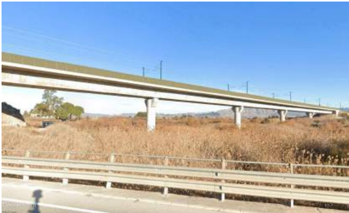
Zona de circulación del flujo, Río Vinalopó, a su paso por línea AVE
