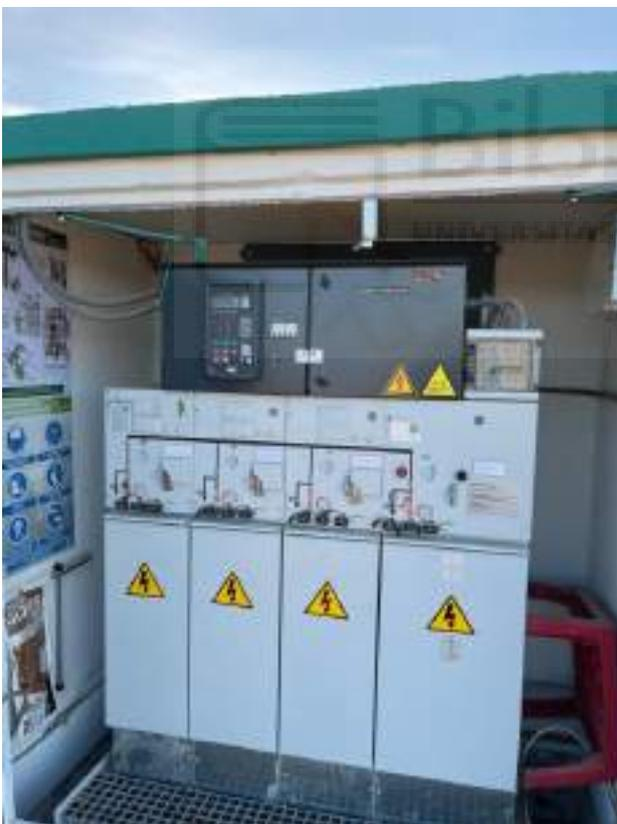
Imagen 2. Celdas de centro de seccionamiento
