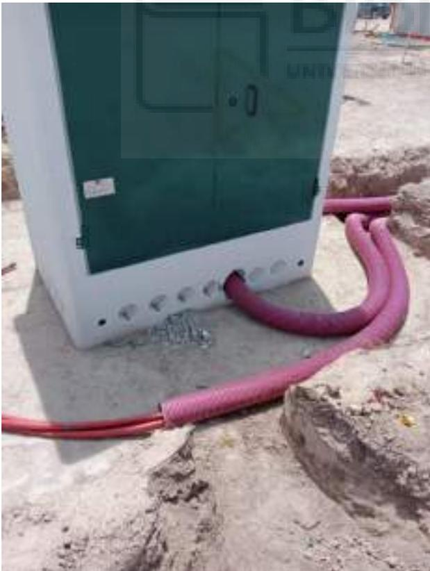
Imagen 4. Entrada de tubos de LSMT a centro de seccionamiento
