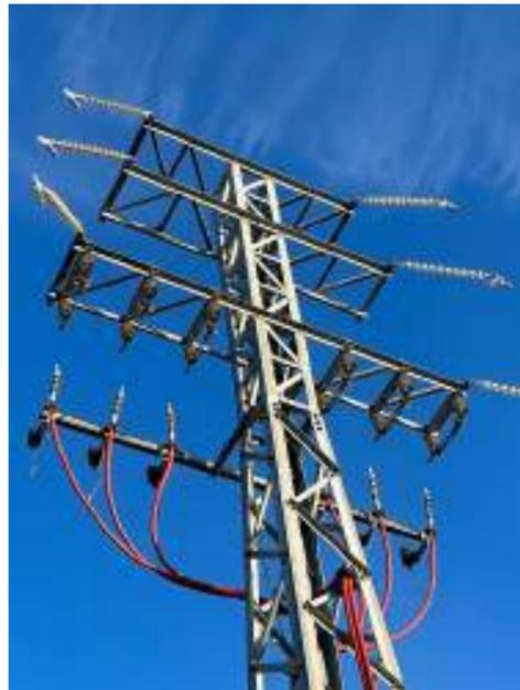
Imagen 14. Detalle de seccionadores cerrados
