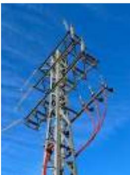
Imagen 8. Aisladores , crucetas, botellas y conexión de LSMT a botellas
