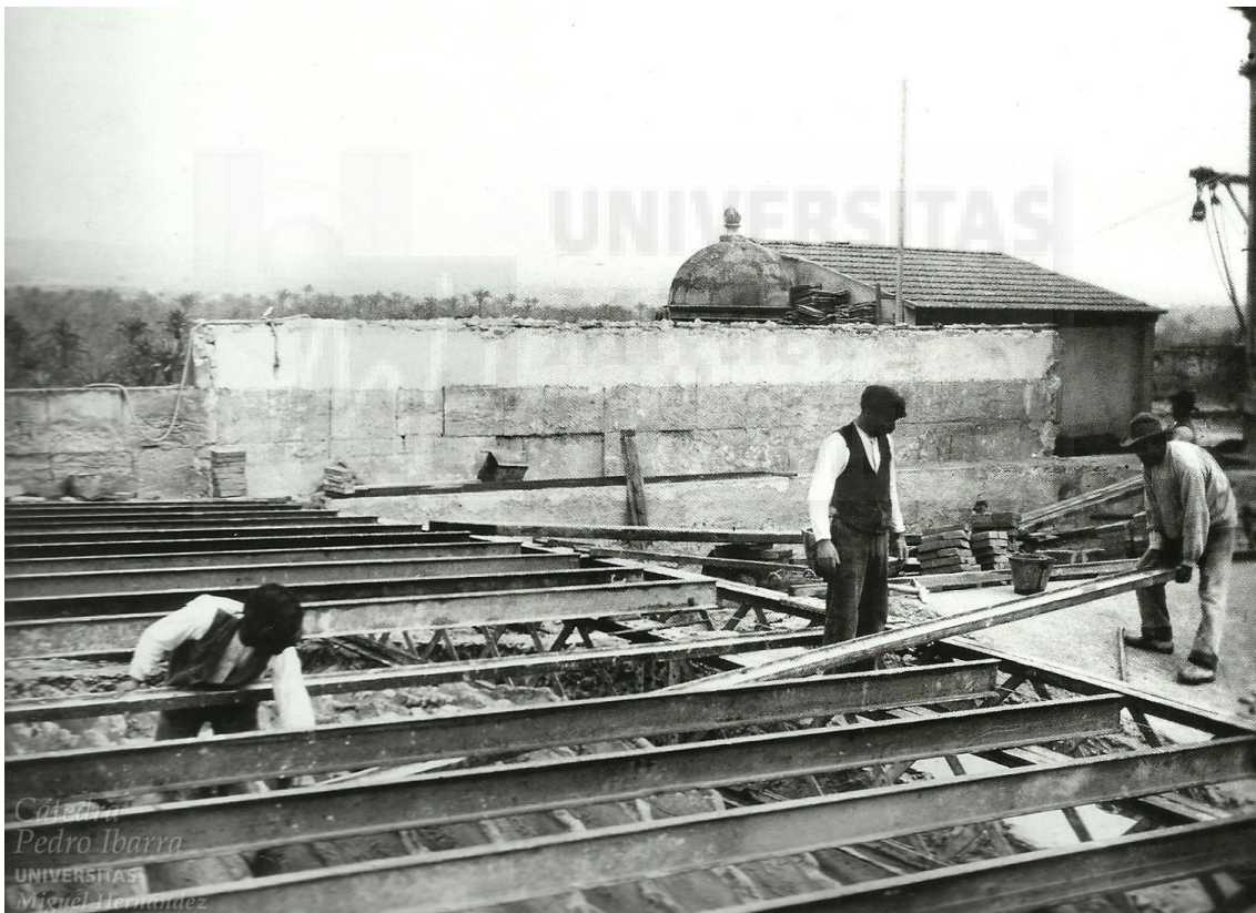
Figura 6. Obreros trabajando en el terrado de Santa María.
