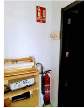
En la imagen de la izquierda se representa el detalle del plano de instalaciones activas contra incendios en el cuarto destinado cuadro eléctrico general, pudiéndose constatar la previsión de un extintor de CO2. En la imagen central se refleja la carencia del mismo y en la imagen de la derecha se puede observar que está ubicado en la conserjería.
