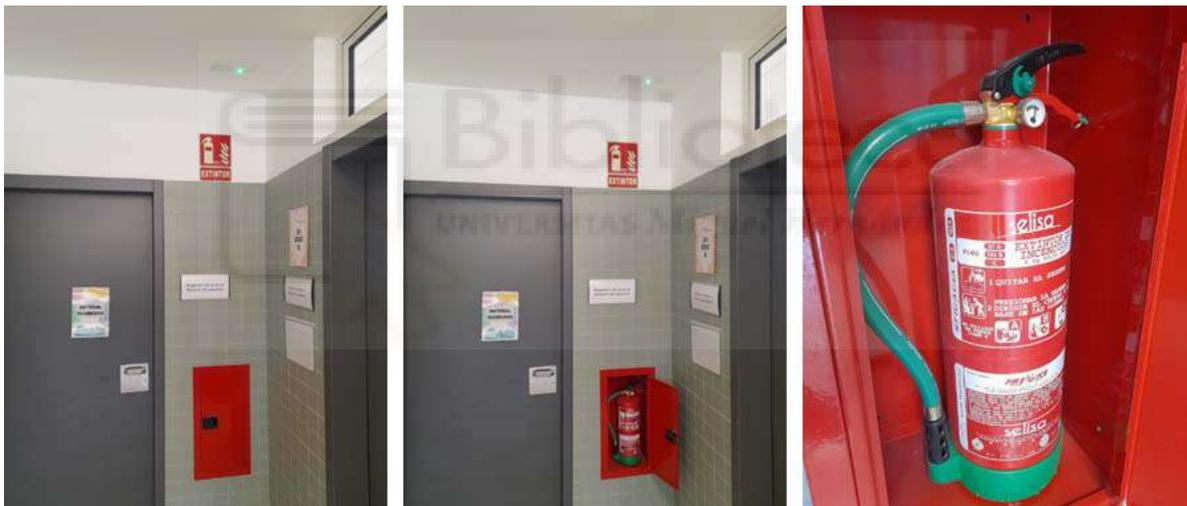
Detalle de la ubicación de los extintores de polvo ABC en pasillos dentro de un armario. Se puede observar la señalización y el alumbrado de emergencia.
