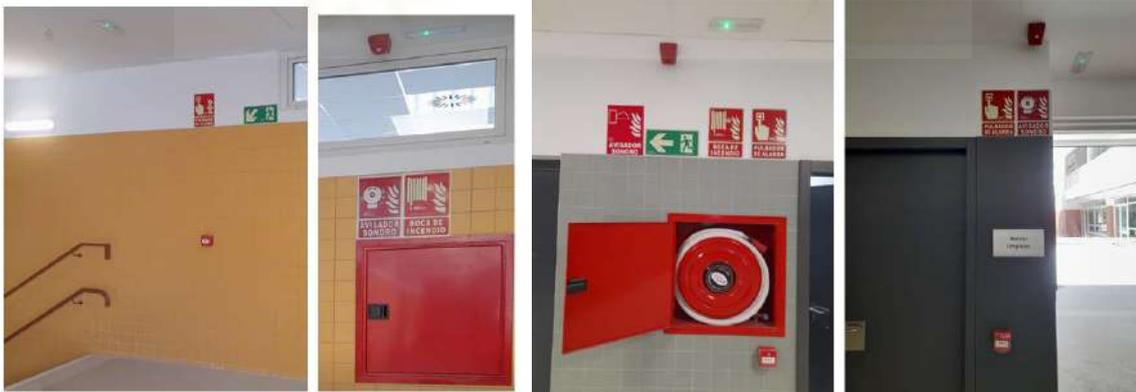
Detalles del avisador sonoro y del pulsador de alarma. Asimismo se puede observar la señalización de dichos medios manuales de protección contra incendios y también la señalización luminiscente de dichas instalaciones citadas (alumbrado de emergencia).
