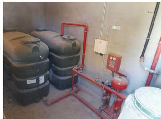
Detalle del equipo de presión contraincendios para proporcionar durante una hora, como mínimo, una presión dinámica mínima de 2 bar en el orificio de salida de cualquier BIE. Está
