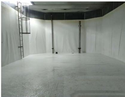
Las escalas fijas que tengan una altura superior a 4 metros dispondrán, al menos a partir de dicha altura, de una protección circundante, arcos de seguridad.
