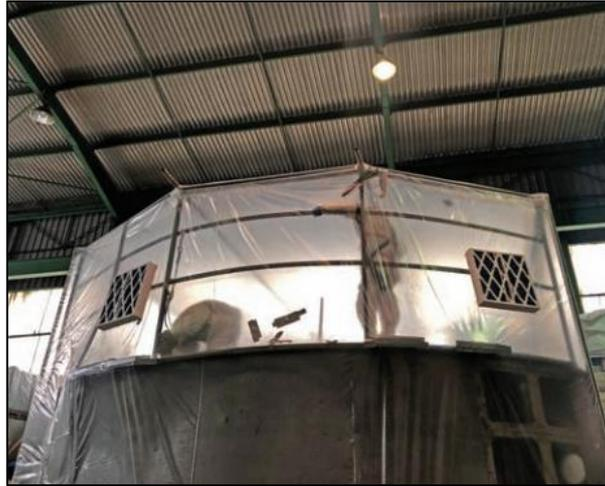
Figura 13. Confinamiento con toma de aire (40).
