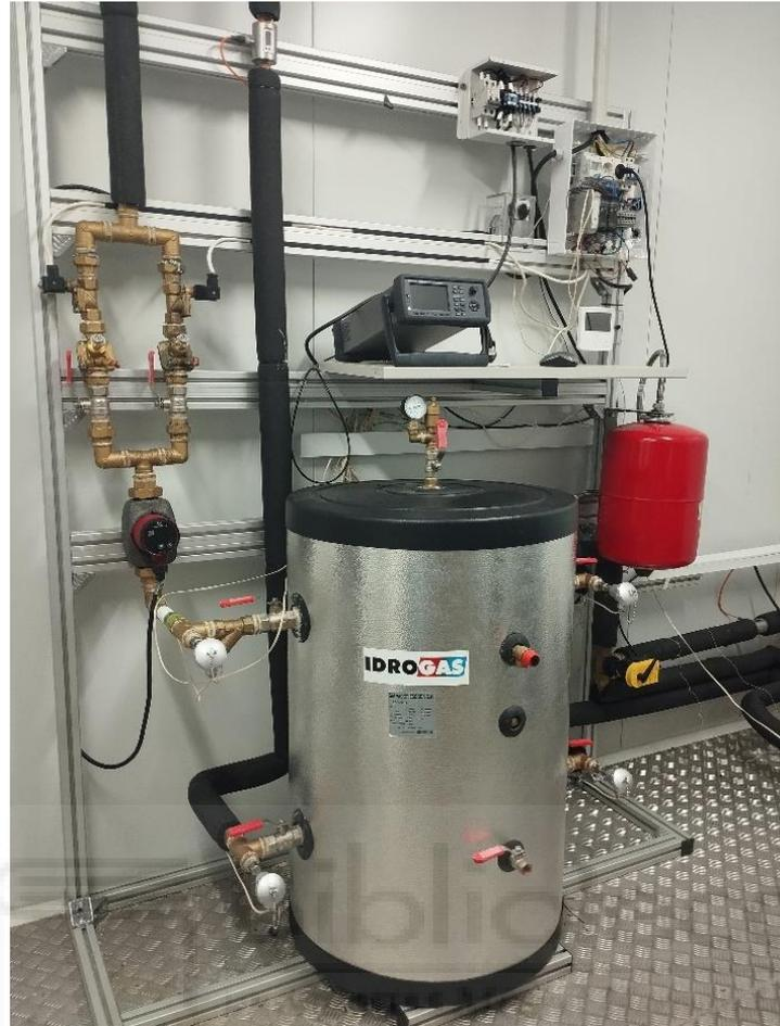
Figura 14. Depósito calefacción
