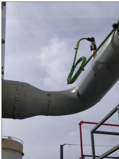
ILUSTRACIÓN 42: SONDA DE TEMPERATURA
