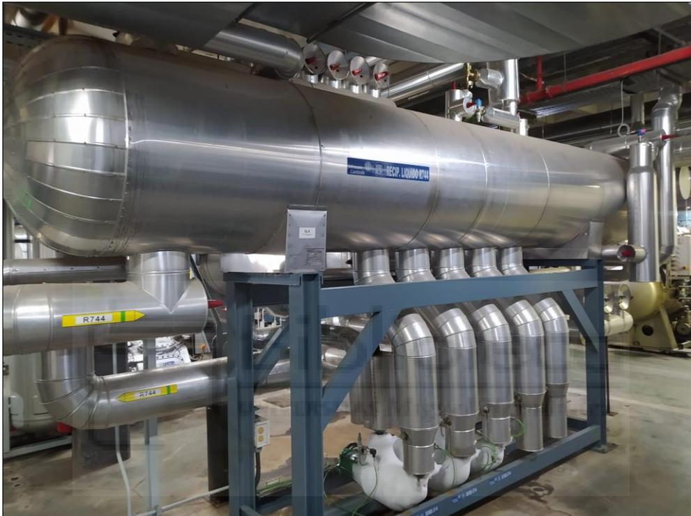
ILUSTRACIÓN 1: INTERCAMBIADOR NH<sub>3</sub>/CO<sub>2</sub>
