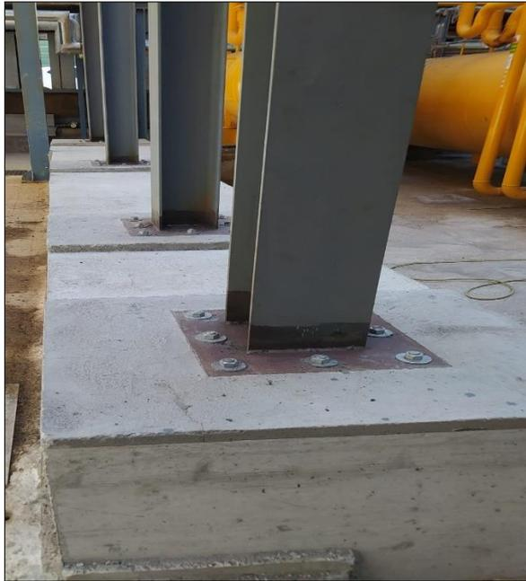
ILUSTRACIÓN 16: ZAPATAS BANCADA
