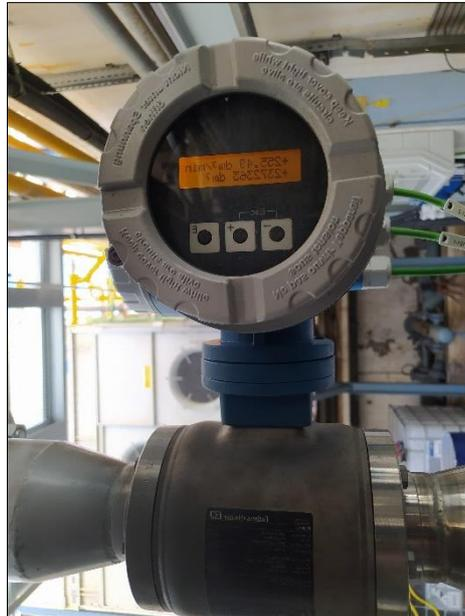
ILUSTRACIÓN 39: CAUDALÍMETRO TORRE REFRIGERACIÓN
