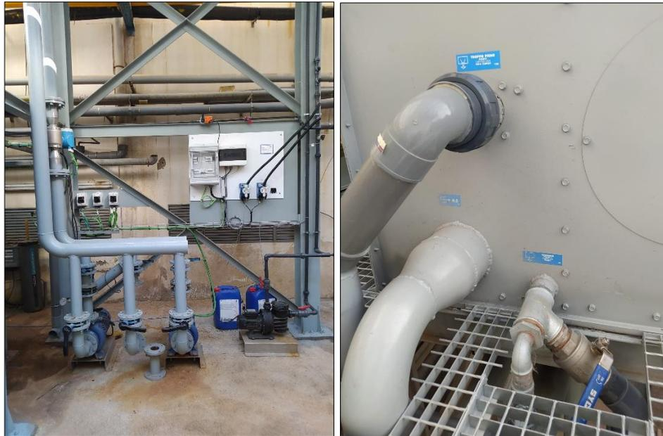
ILUSTRACIÓN 40: SISTEMA BOMBEO TORRE REFRIGERACIÓN Y CANALIZACIÓN INFERIOR
