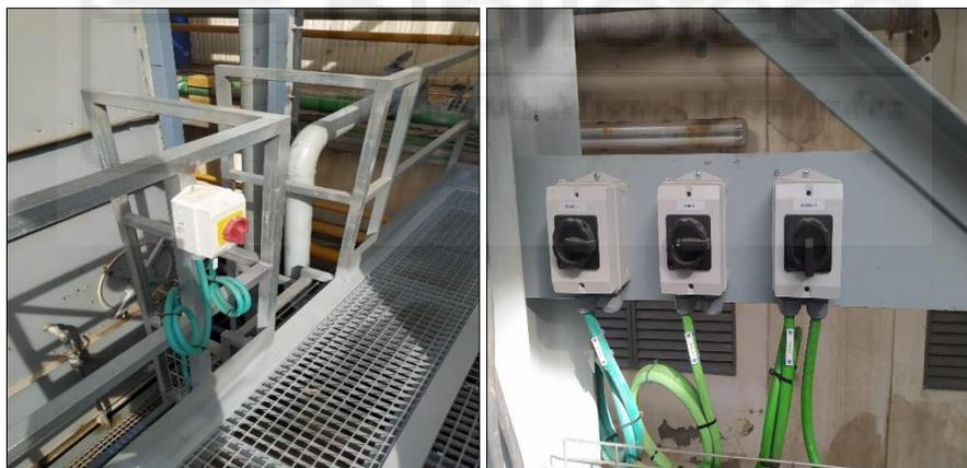
ILUSTRACIÓN 43: INTERRUPTOR GENERAL E INTERRUPTORES BOMBAS
