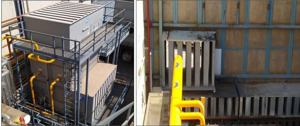
ILUSTRACIÓN 29: SILENCIADORES CONDENSADOR Y PAREDES FÁBRICA
