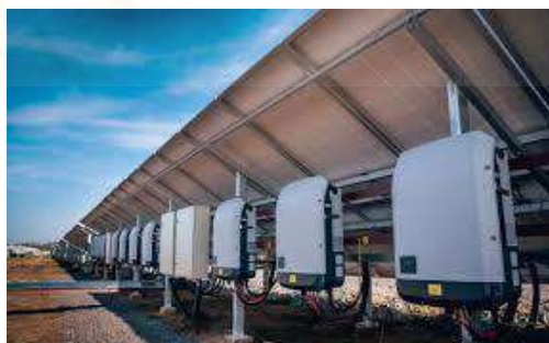
Figura 40: Inversores de cadena
