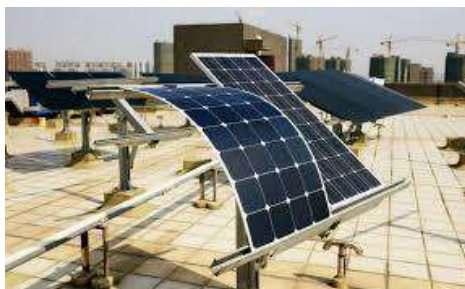
Figura 33: Panel solar de capa fina
