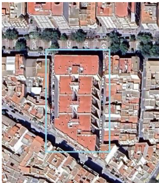
Figura 50: Vista aérea del edificio
