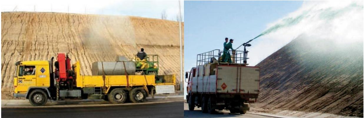
Imagen hidrosiembras en taludes de carretera. **Foto 10.** Fotografías de María Altamirano (OHL), en libro de: Valladares F. et al., 2011. Foto izquierda. Cap. 1 (pág.: 26), foto derecha: Cap. 7 (pág.:192).
