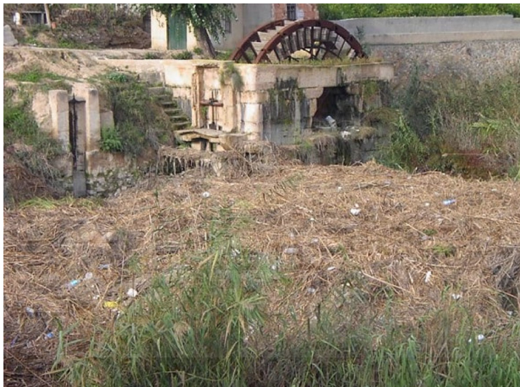
Figura 3.1.1. Acumulación de cañas (bardomera) en el cauce del río Segura en las Norias en Orihuela.
