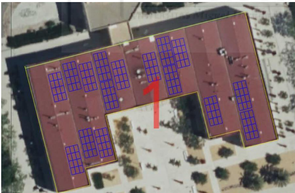
Ilustración 17: instalación sobre cubierta Edificio Vinalopó
