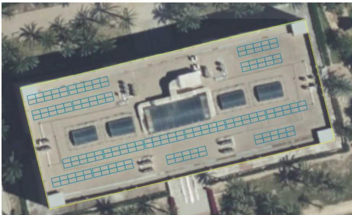
Ilustración 19: instalación sobre cubierta en Edificio La Galia
