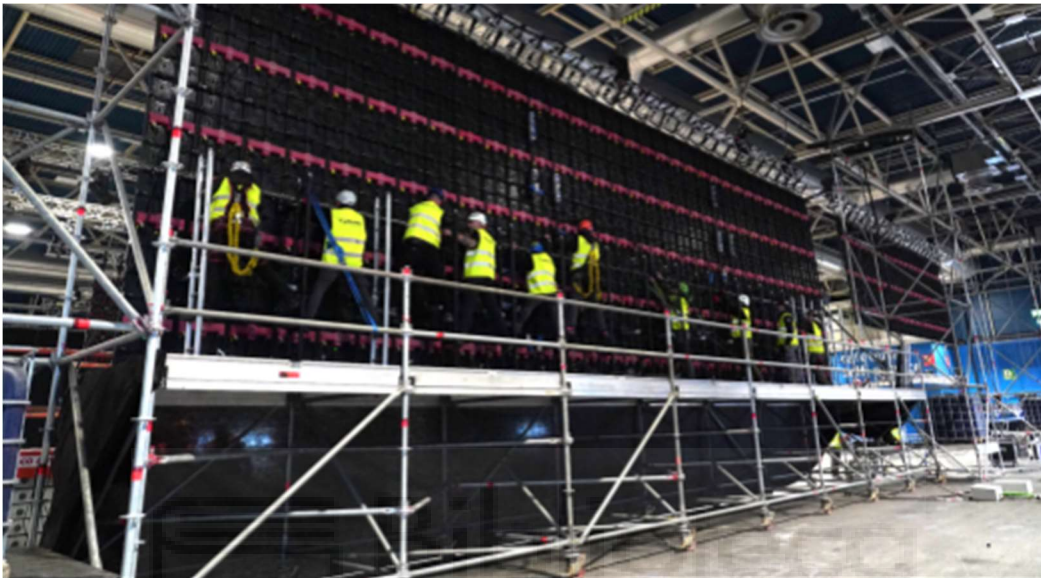
Figura 42. Momento de unión entre ambas mitades de la pantalla. Fuente: elaboración propia.
