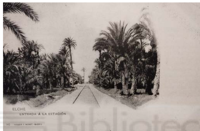
Figura 11: Entrada a la estación, Hauser y Menet.
