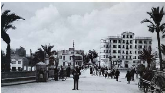
Figura 21: Vista del Puente de Canalejas antigua
