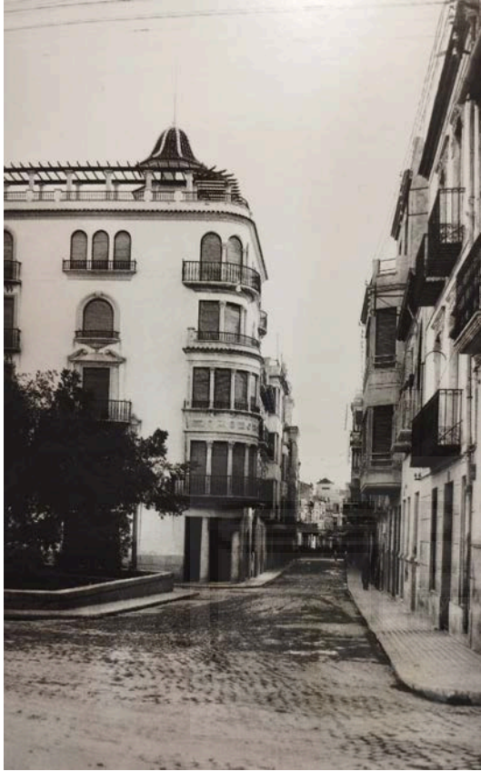
Figura 57: Foto antigua Plaza de La Mercé. Manuel Arribas Fuente: https://www.elche.es
