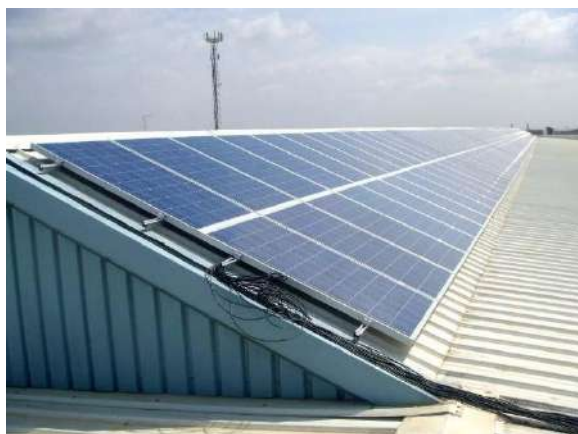
Ilustración 7. Ejemplo de estructura coplanar sobre cubierta inclinada.
