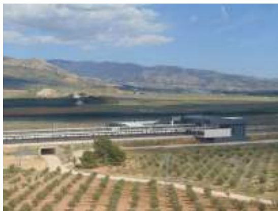
Imagen 33: Estación Villena alta velocidad.
