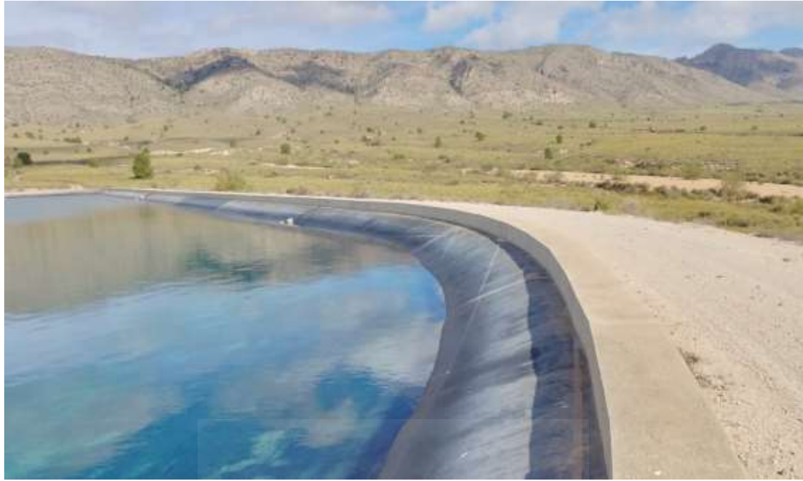
Vista desde la Balsa "Campana II".
