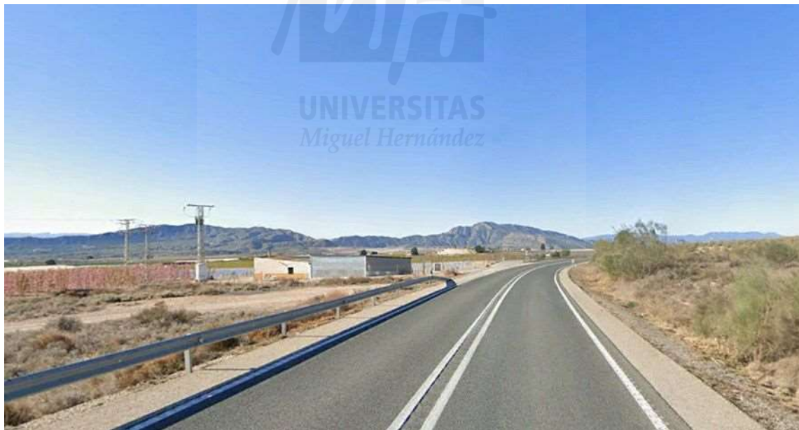
Afección RM-714 y separación en dos volúmenes.
