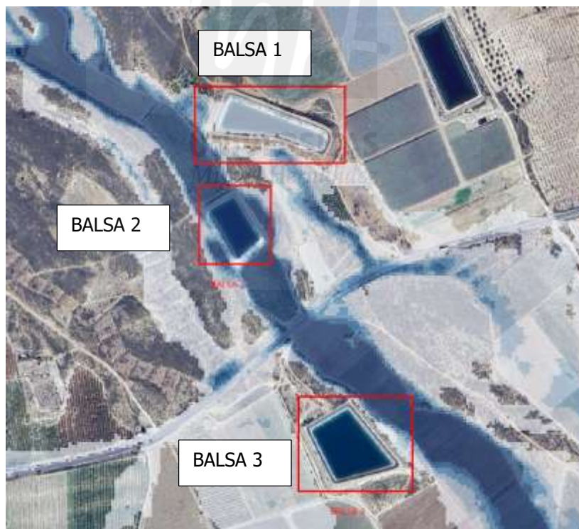
Figura 8: Balsas afectadas consideradas para la rotura en cadena.
