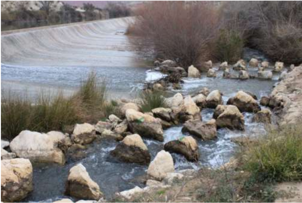
Zona de encauzamiento del flujo en el "Río Segura".
