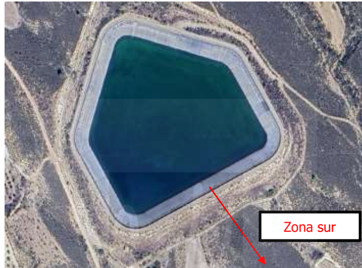
Figura 1: Punto de rotura de la balsa (Fuente; elaboración propia)
