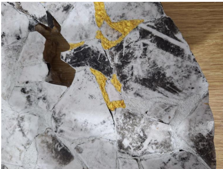
Fig. 7: Pegado de las piezas de azulejo y pintado de uniones
