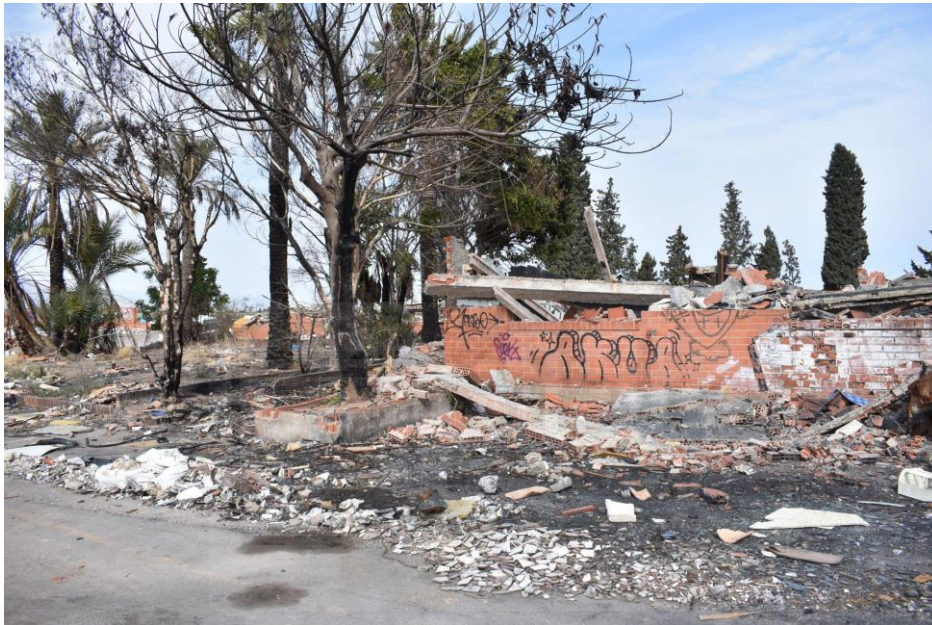
Fig. 5: Zona de la fábrica abandonada de donde se recogieron los azulejos
