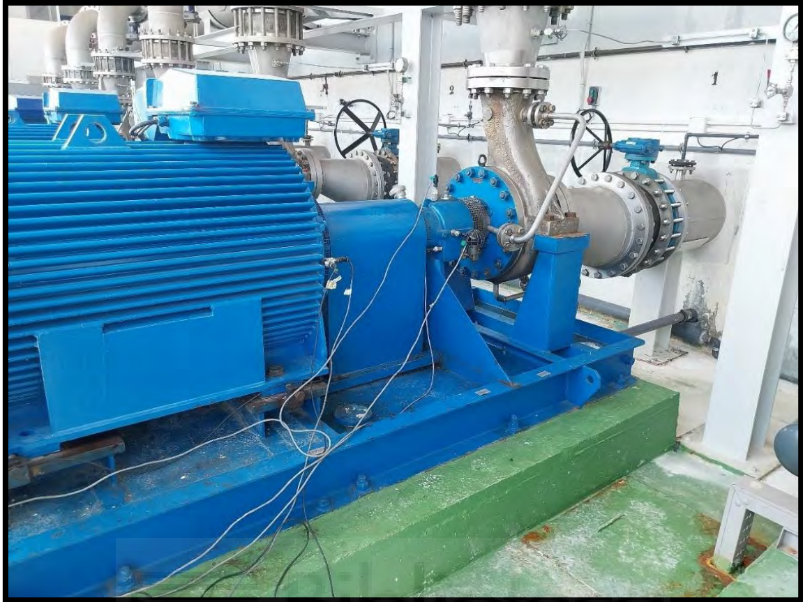
Ilustración 17-3: Foto de la ubicación de los sensores en el equipo
